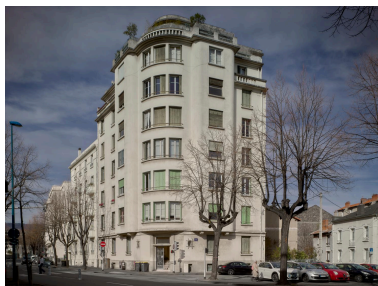
Façade d'angle rue Ledru et boulevard Cote-Blatin Phot. Christian Parisey IVR84_20236300314NUC4A
