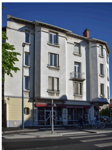
façade sur le boulevard Cote-Blatin Phot. Félicie Fougère IVR84_20246301183NUCA
