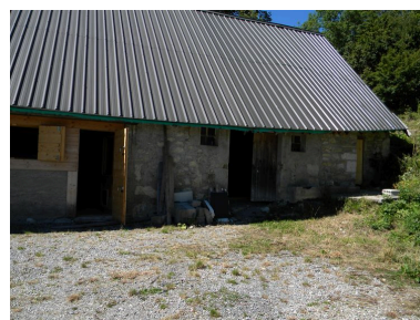
Vue de la partie agricole de la ferme remaniée du Chénay. Phot. Jérôme Daviet IVR82_20127400681NUCA
