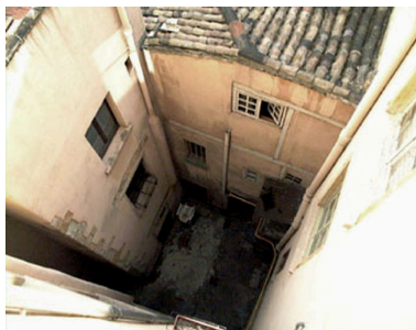
Vue de la cour commune aux 5 et 7 rue Bellière, 10 rue Ferrachat et 12 rue du Doyenné Phot. Maryannick Chalabi IVR82_20006900183NUCA
