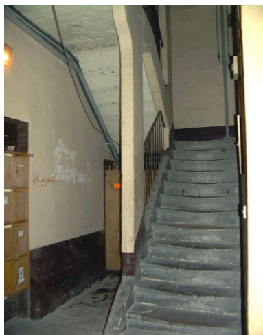
Vue de l'escalier commun aux 7 rue Bellière et 10 rue Ferrachat Phot. Maryannick Chalabi IVR82_20006900157NUCA
