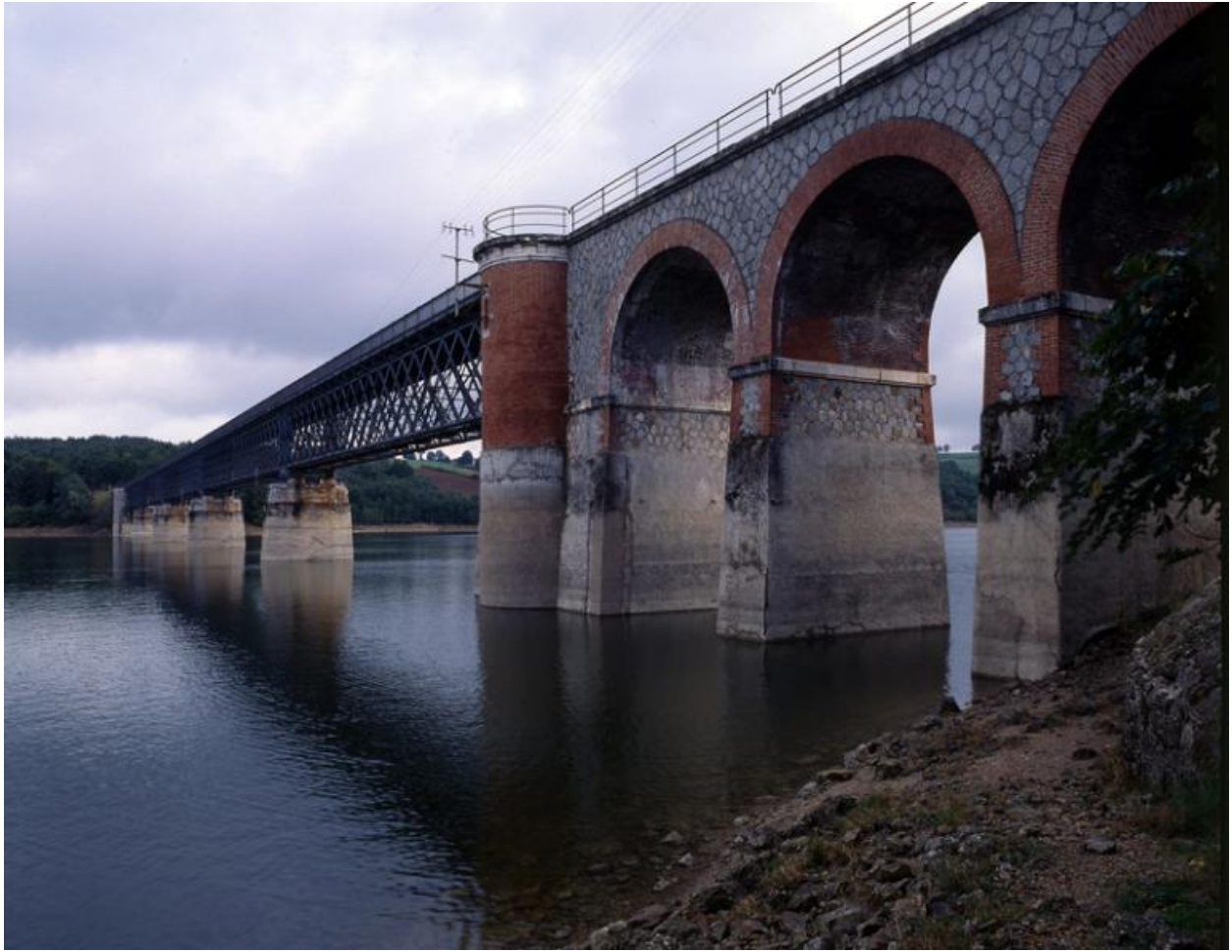
Viaduc de Ribeyrès, détail (en 1992).
