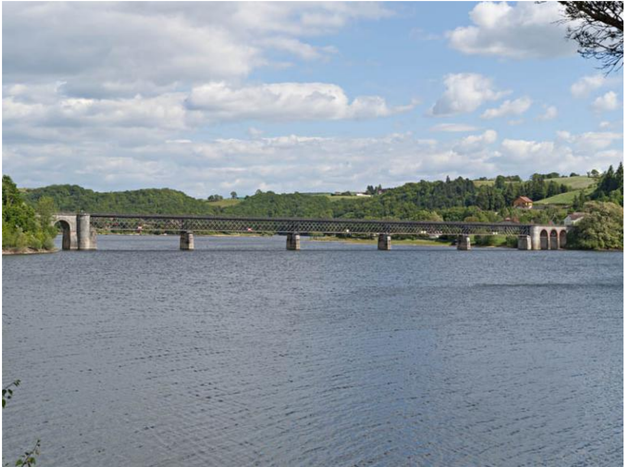
Vue générale du viaduc de Ribeyrès enjambant le lac de barrage de Saint-Etienne-Cantalès.
