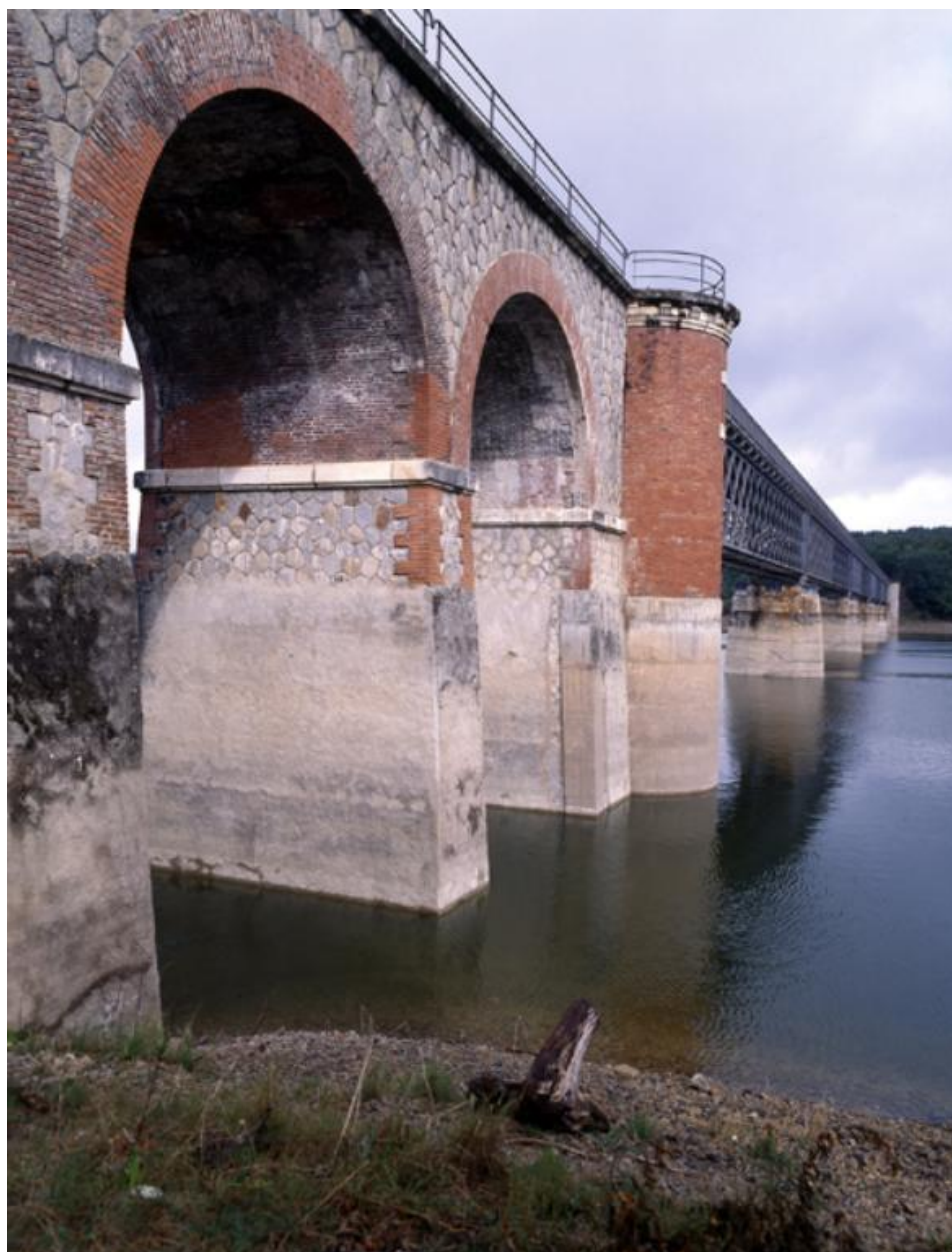
Viaduc de Ribeyrès, détail (en 1992).
