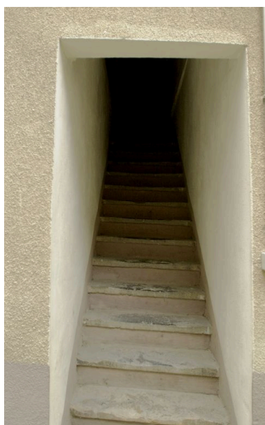
Escalier d'accès à l'étage Phot. Maryannick Chalabi IVR82_20086900689NUCA
