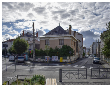
Élévation à l'angle de la rue de Vallières et du boulevard Jean-Jaurès. Vue depuis la place Littré. Phot. Félicie Fougère IVR84_20256300412NUCA
