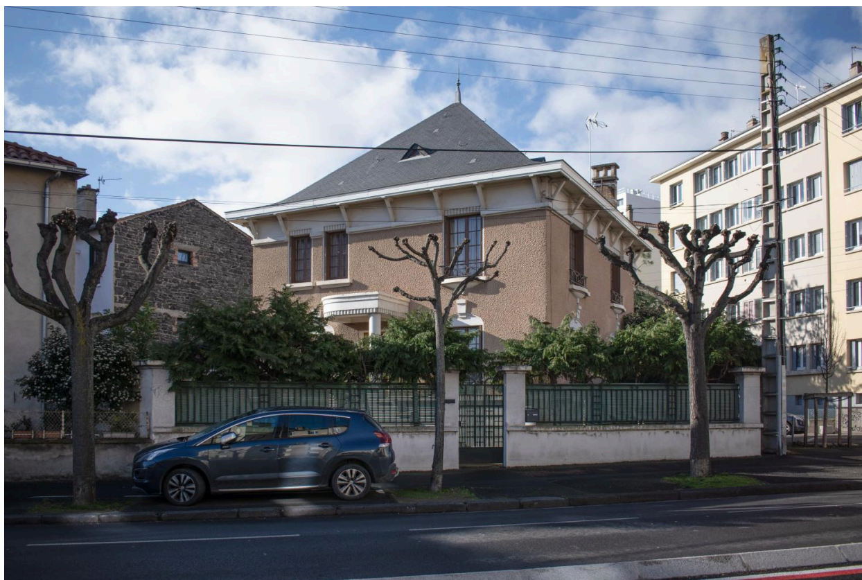
Façade sur le boulevard Jean-Jaurès
