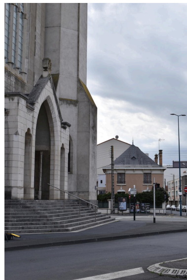
Le porche de l'église. A l'arrière-plan, la maison du n°63 boulevard Jean-Jaurès Phot. Félicie Fougère IVR84_20256300181NUCA
