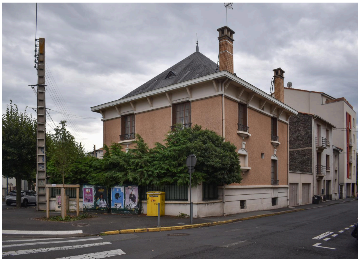
Angle de la rue de Vallières et du boulevard Jean-Jaurès
