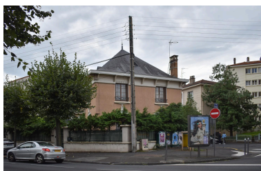
Élévation latérale sur la place Littré Phot. Félicie Fougère IVR84_20256300418NUCA
