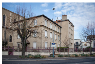
Ancienne école ménagère, 54 boulevard Jean-Jaurès. Façade sur le boulevard du bâtiment d'origine (1927, Charles Marc architecte). Élévation latérale de l'extension (1947, Jean Bosser architecte) Phot. Félicie Fougère IVR84_20256300266NUCA
