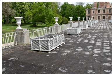
Vue d'ensemble Phot. Maryse Durin-Tercelin IVR84_20226300630NUCA
