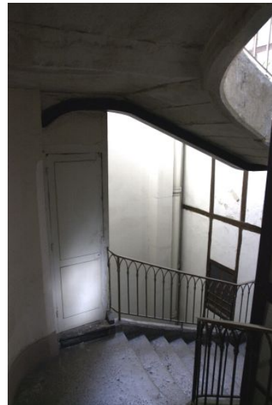
Escalier, quatrième étage, détail d'un repos Phot. Lore Derail IVR82_20036901400NUCA
