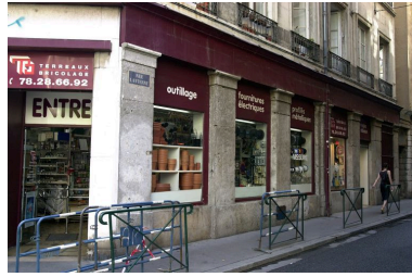
Façade secondaire rue Lanterne, rez-de-chaussée Phot. Lore Derail IVR82_20036901396NUCA
