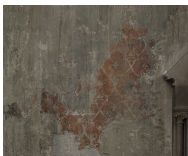
Détail des peintures du mur nord du collatéral nord, travée II. Phot. Eric Dessert IVR82_20044201786NUCA
