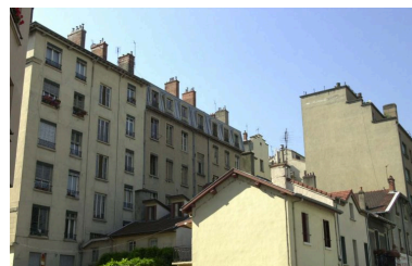
Elévation postérieure Phot. François Blanchetière IVR82_20016902318NUCA
