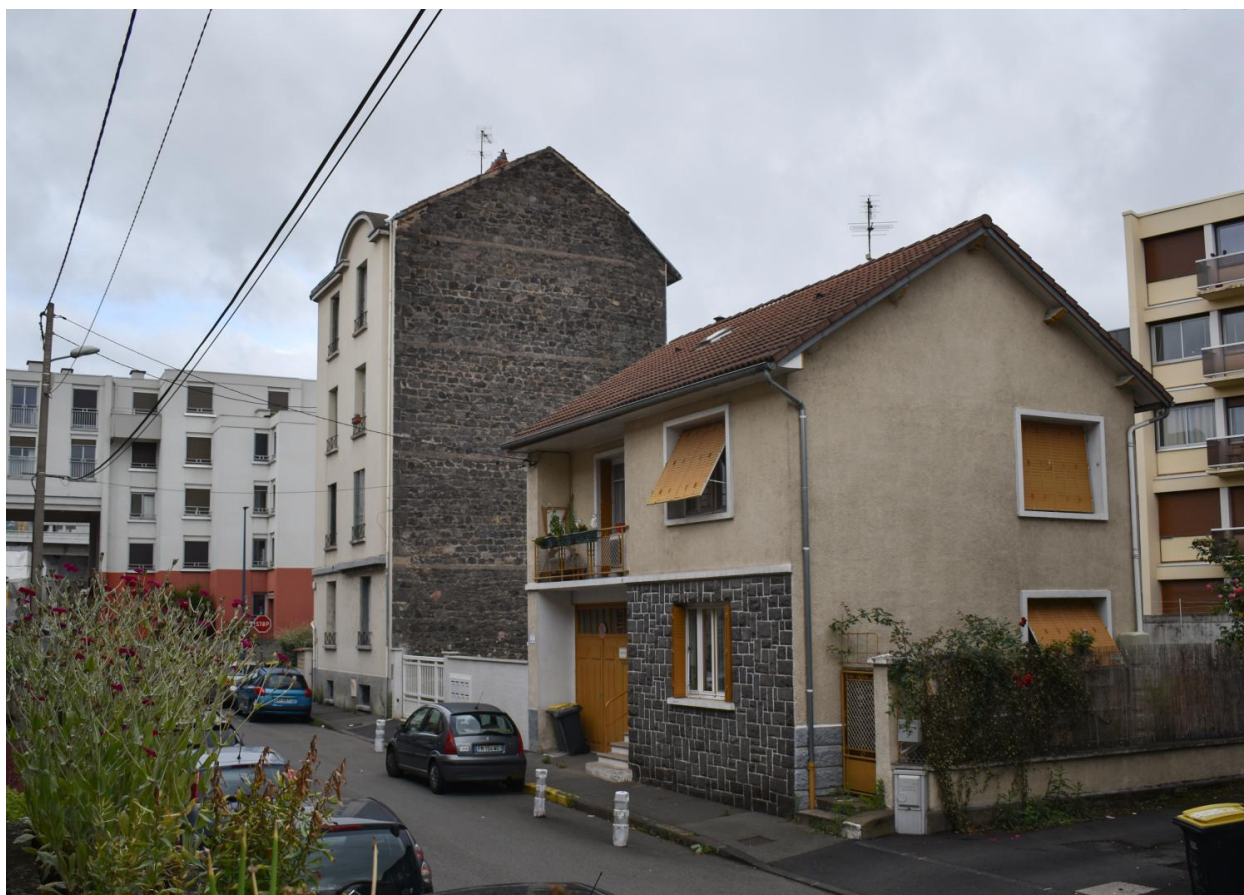
Façades sur la rue Philippe-Glangeaud
