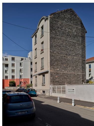
Façade sur la rue Philippe- Glangeaud et élévation aveugle sur l'allée de desserte du coeur d'îlot Phot. Christian Parisey IVR84_20246301616NUCA
