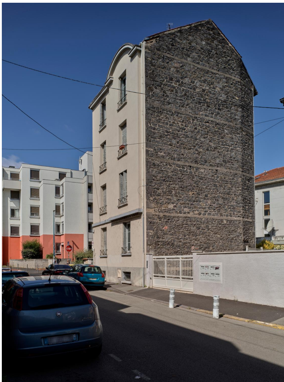
Façade sur la rue Philippe-Glangeaud et élévation aveugle sur l'allée de desserte du coeur d'îlot
