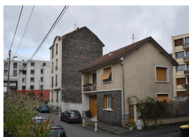
Façades sur la rue Philippe-Glangeaud Phot. Félicie Fougère IVR84_20246301618NUCA
