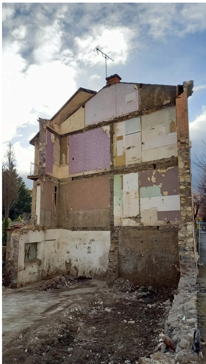
Elévation orientale du 105 boulevard Lavoisier après destruction de l'immeuble (janvier 2024)
