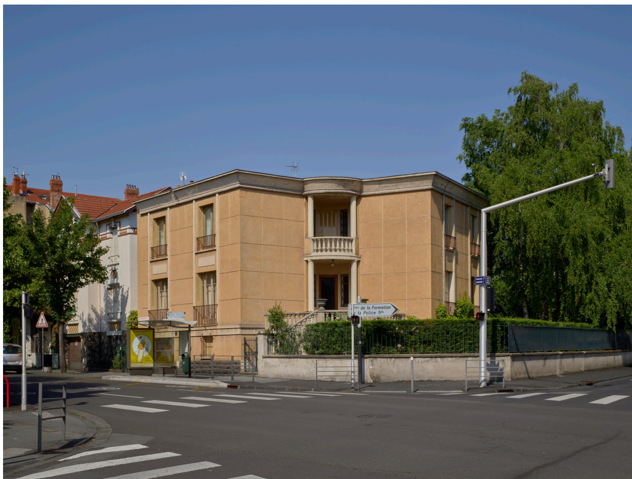
Vue de l'élévation principale de la maison dite "villa Vigneron" depuis le carrefour du boulevard Lavoisier et de la rue Paul Diomède
