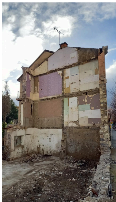
Elévation orientale du 105 boulevard Lavoisier après destruction de l'immeuble (janvier 2024) Phot. Félicie Fougère IVR84_20246300004NUCA
