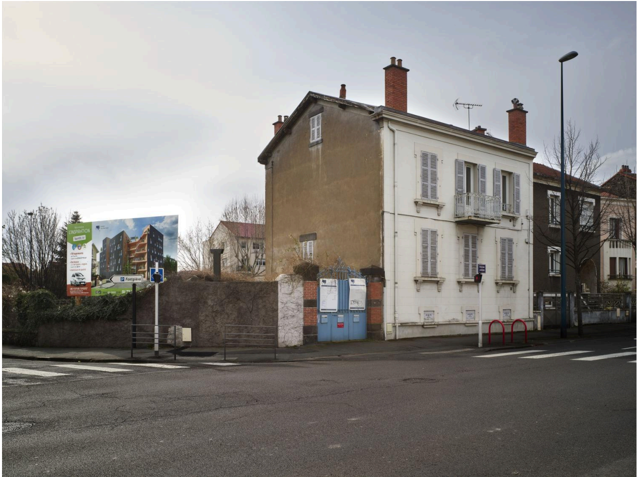
Élévation sur le boulevard
