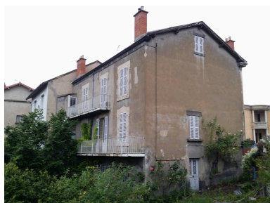
Vue de l'élévation latérale et postérieure Phot. Félicie Fougère IVR84_20236300694NUCA
