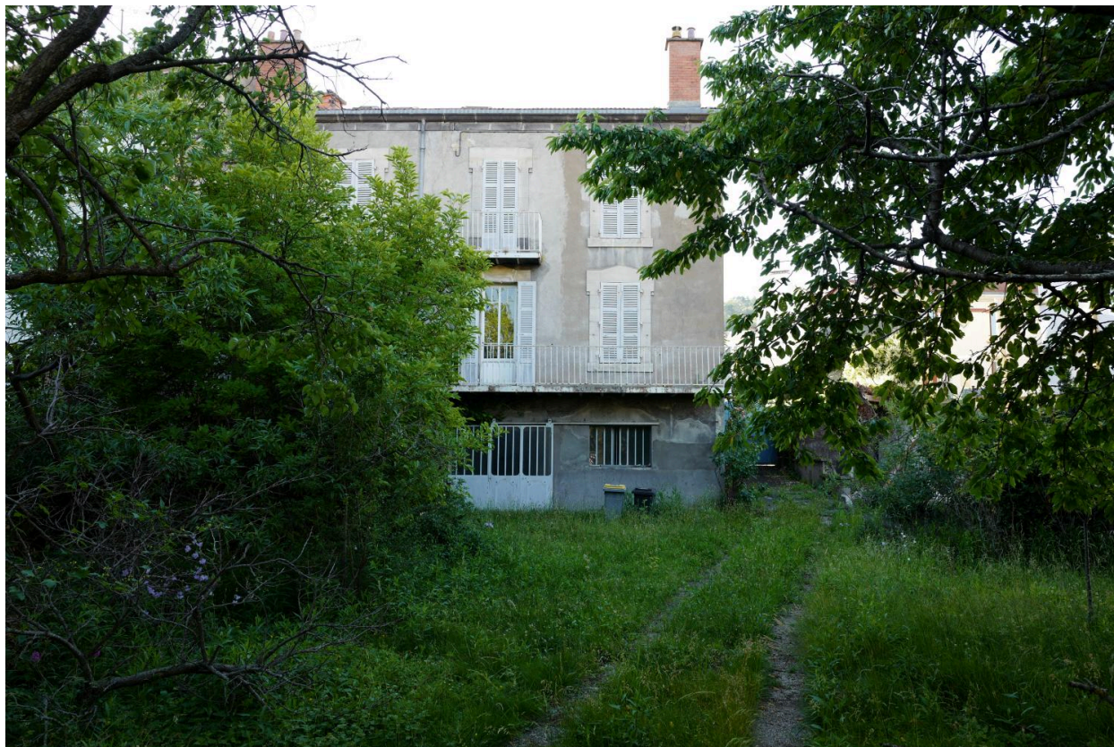
Elévation postérieure sur le jardin, vue depuis l'entrée du jardin rue du Clos Notre-Dame
