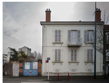
Elévation sur le boulevard Phot. Christian Parisey IVR84_20236300040NUC4A
