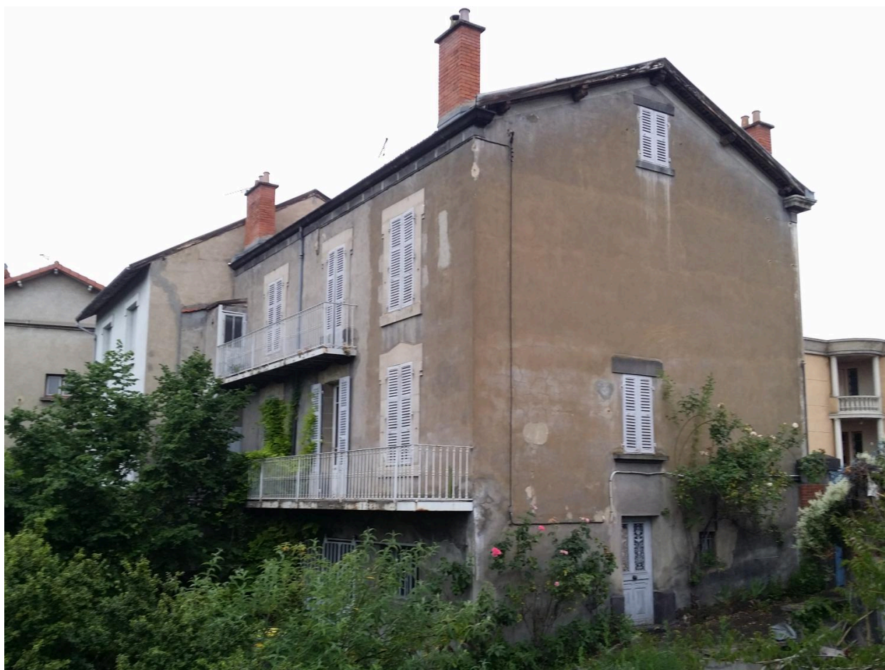
Vue de l'élévation latérale et postérieure
