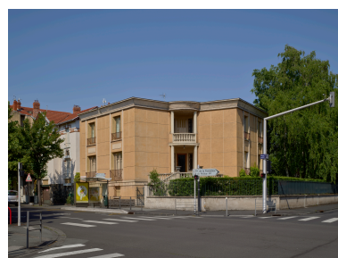
Vue de l'élévation principale de la maison dite "villa Vigneron" depuis le carrefour du boulevard Lavoisier et de la rue Paul Diomède Phot. Christian Parisey IVR84_20236300504NUC4A
