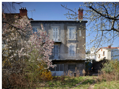
Elévation sur le jardin Phot. Christian Parisey IVR84_20236300045NUC4A
