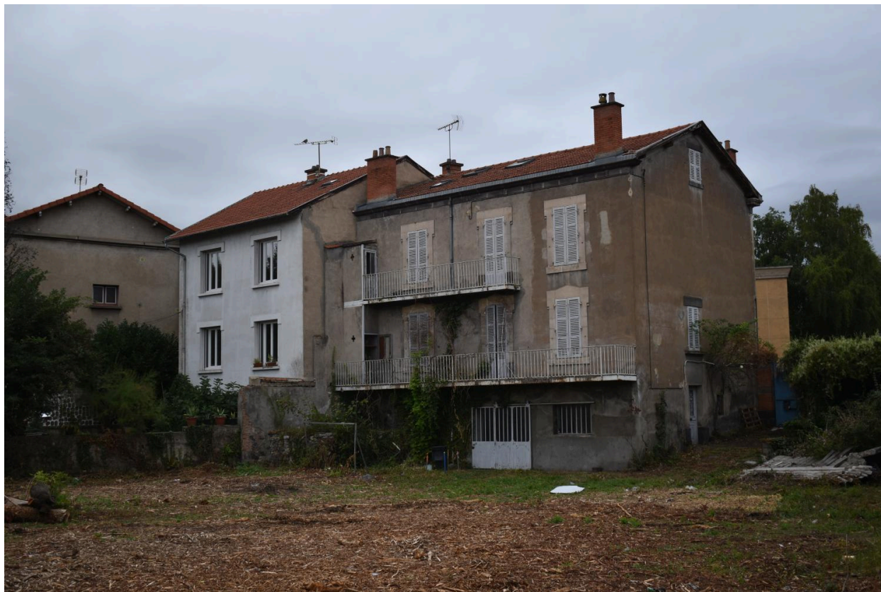
Elévation postérieure après destruction du jardin (août 2023)
