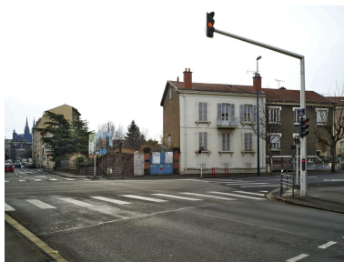
Elévation sur le boulevard Phot. Christian Parisey IVR84_20236300039NUC4A
