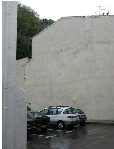
Terrain nu actuellement parking du 27, 29 rue Druge Phot. Benoît Chapelle IVR82_20073800168NUCA
