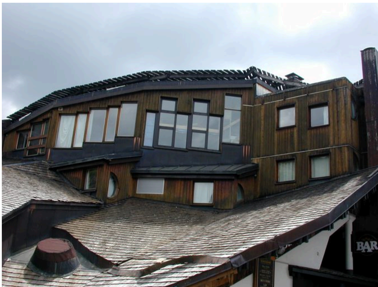
Elévation nord, au-dessus du toit du centre commercial
