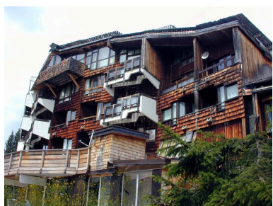
Elévation sud-ouest Phot. Jean-François Lyon-Caen, Phot. C. Salomon-Pelen IVR82_20087401105NUCA
