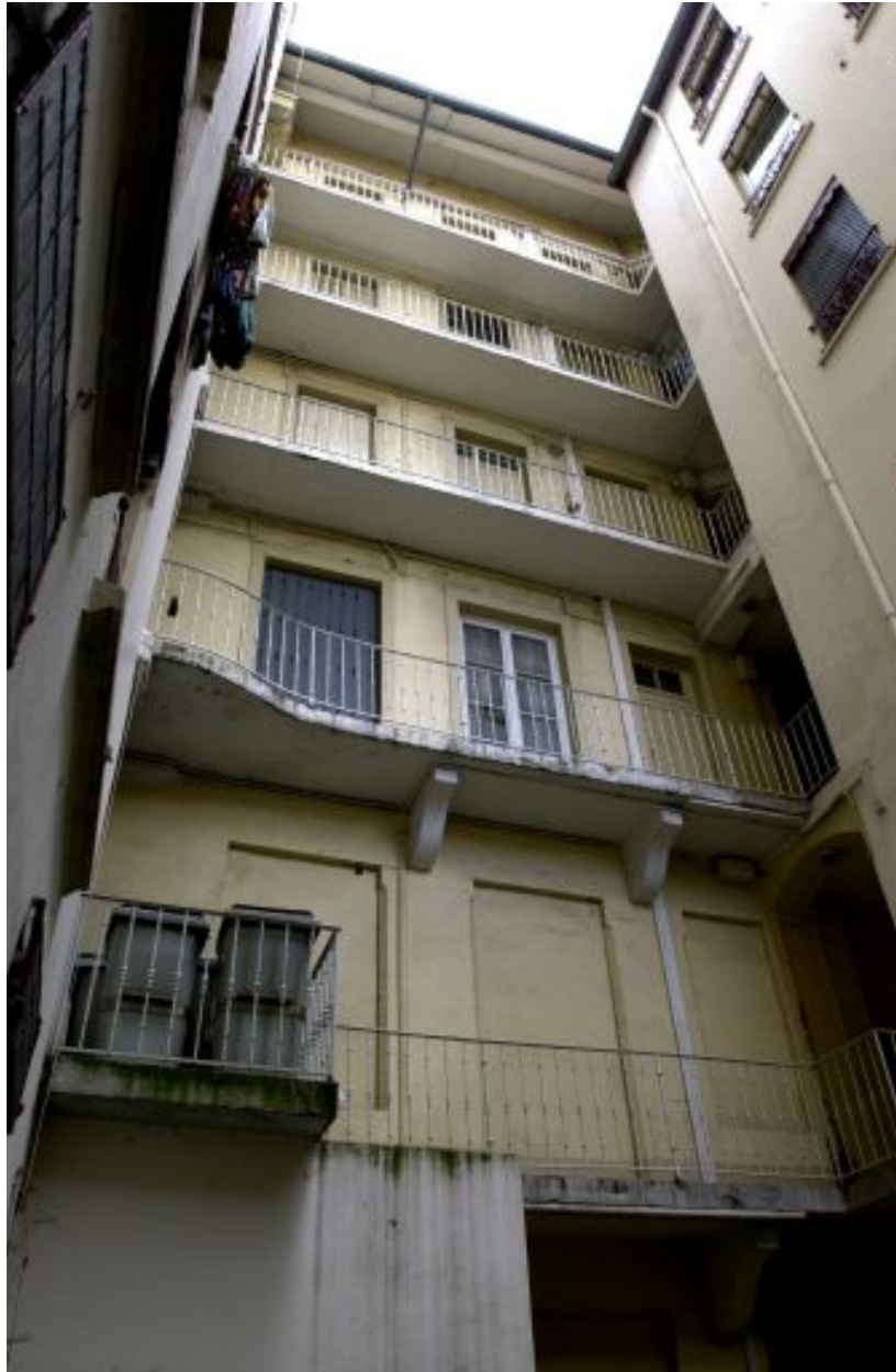
Vue des coursières contre l'élévation postérieure
