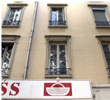
Détail des fenêtres Phot. François Blanchetière IVR82_20016901951NUCA
