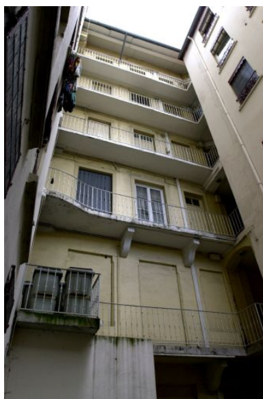
Vue des coursières contre l'élévation postérieure Phot. François Blanchetière IVR82_20016901953NUCA
