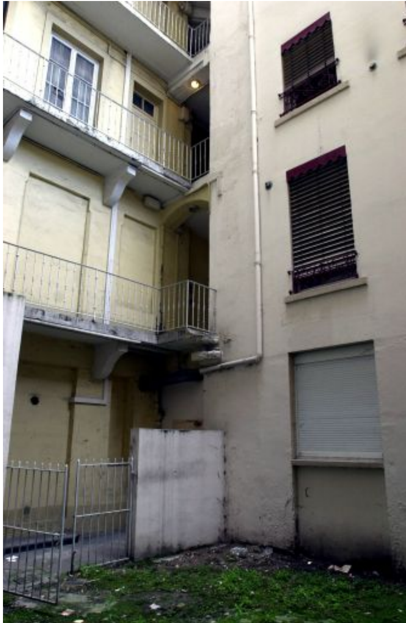
Vue de la cour et des coursières contre l'élévation postérieure
