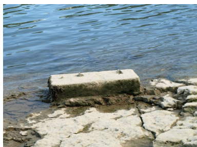
Bloc de béton repéré en rive droite (vestige de l'ancien bac ?) Phot. J. Marasi IVR82_20100100271NUCA
