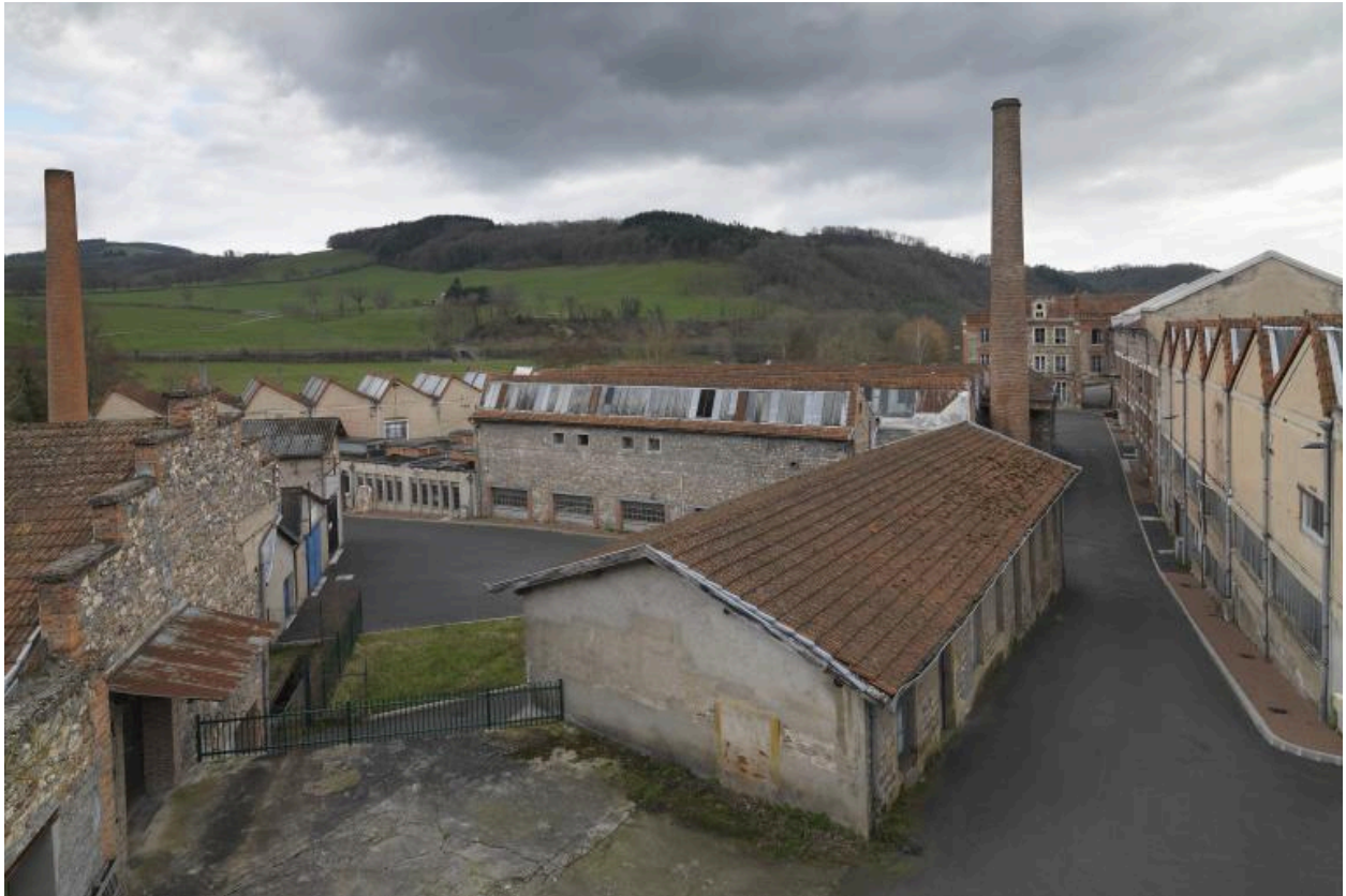
Vue d'ensemble des usines Conté de Régny.
