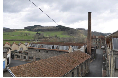
Vue d'ensemble est du site Phot. Nadine Halitim-Dubois IVR84_20164200108NUCA
