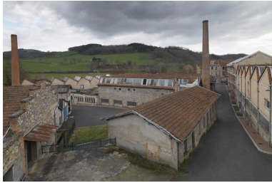
Vue d'ensemble des usines Conté de Régný. Phot. Thierry Leroy IVR84_20164200152NUCAQ
