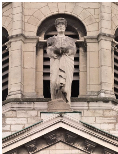
Vue générale. Phot. Didier Gourbin IVR82_20116904762NUCA
