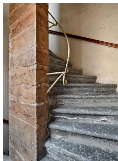
Escalier secondaire est : noyau et volée Phot. Thierry Leroy IVR84_20196900520NUCAQ
