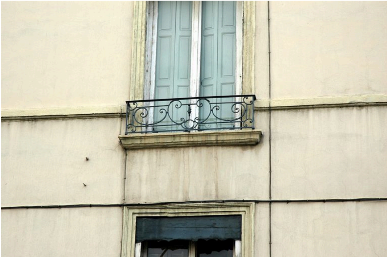
Elévation antérieure : deuxième étage carré, travée axiale, garde-corps
