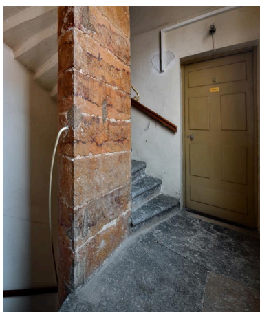
Escalier secondaire est : noyau et palier Phot. Thierry Leroy IVR84_20196900504NUCAQ
