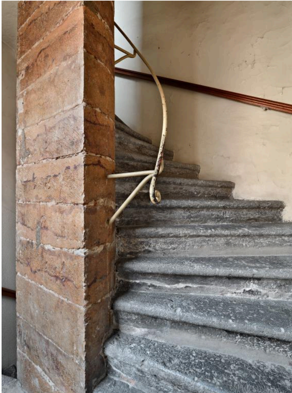
Escalier secondaire est : noyau et volée
