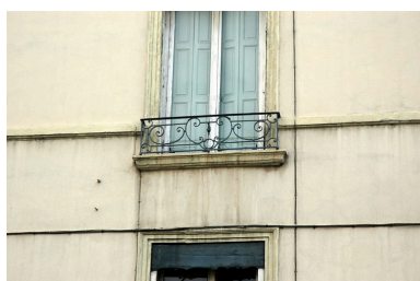
Elévation antérieure : deuxième étage carré, travée axiale, garde-corps Phot. Véronique Belle IVR82_20076901032NUCA
