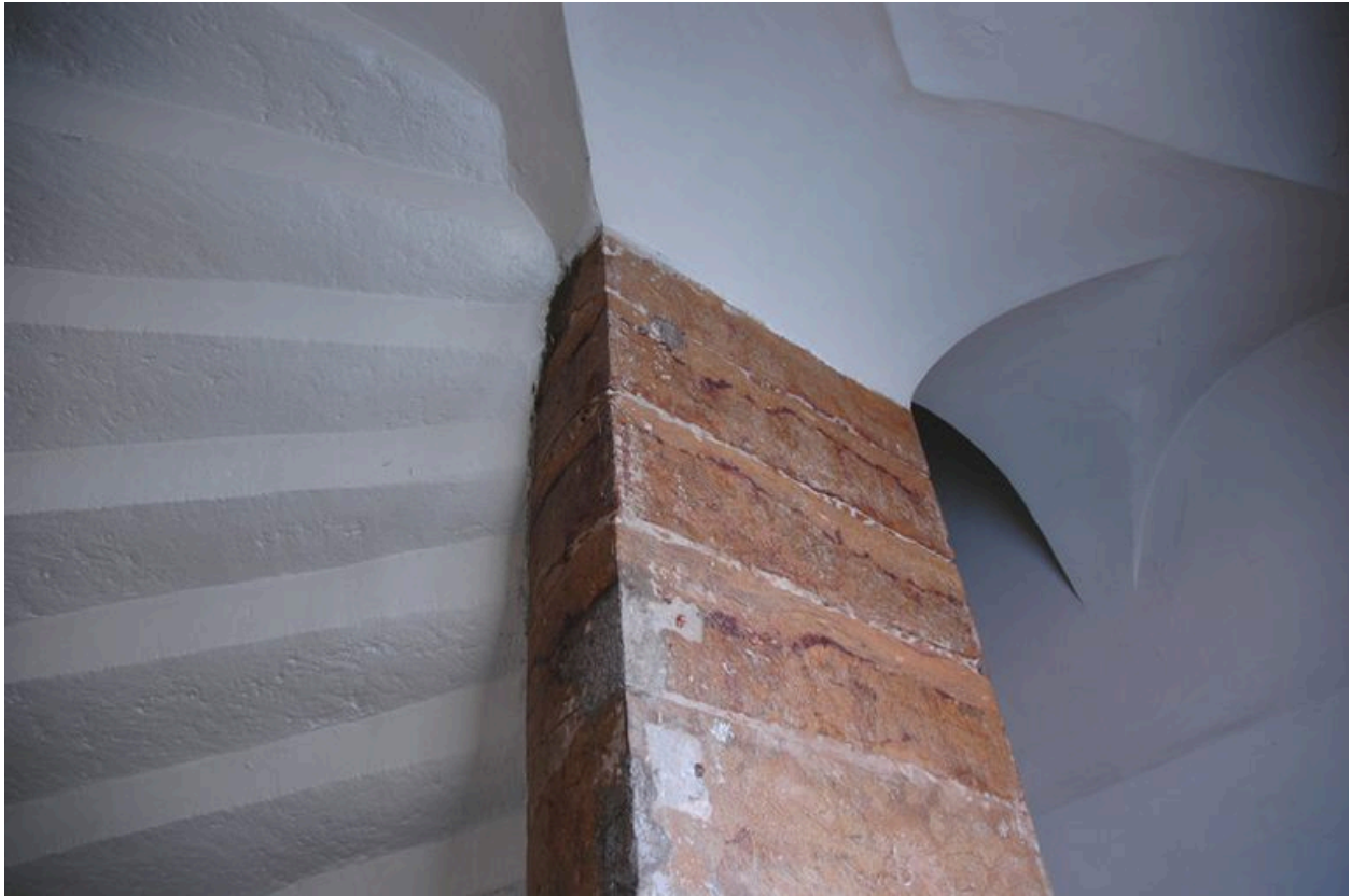
Demi colonne servant de noyau à l'escalier secondaire, angle nord-est de la cour
