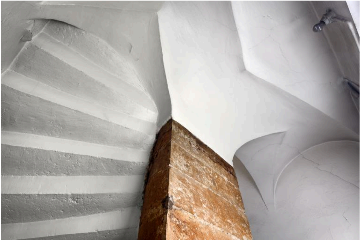
Escalier secondaire est : couverture du palier en berceau à lunettes
