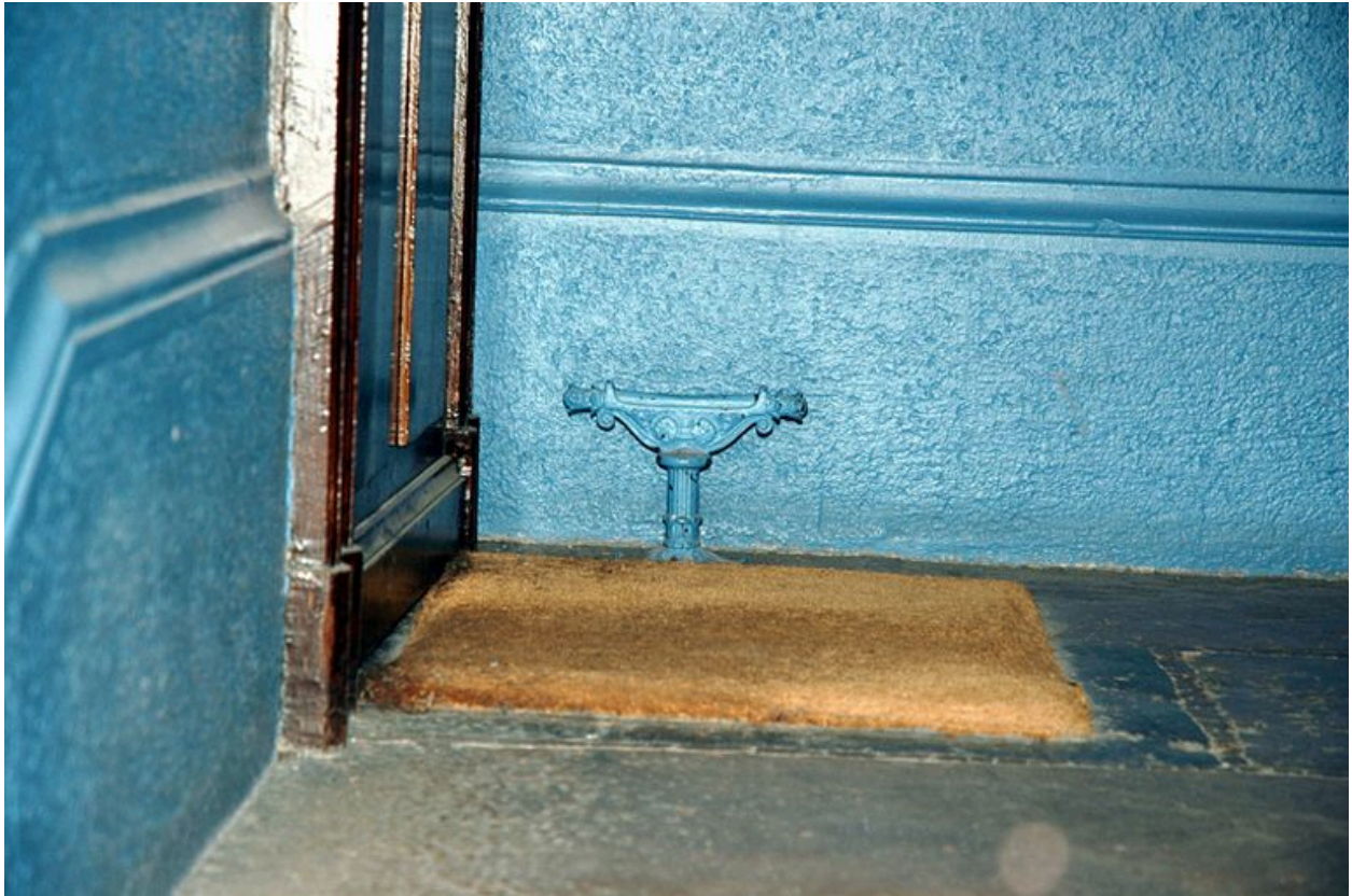
Corps de bâtiment sur rue : décrotoir sur palier
