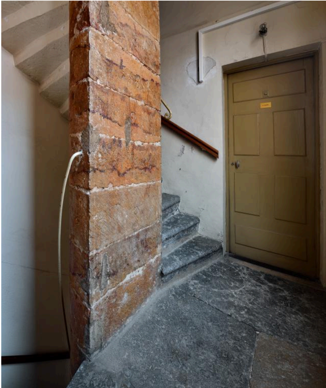
Escalier secondaire est : noyau et palier
