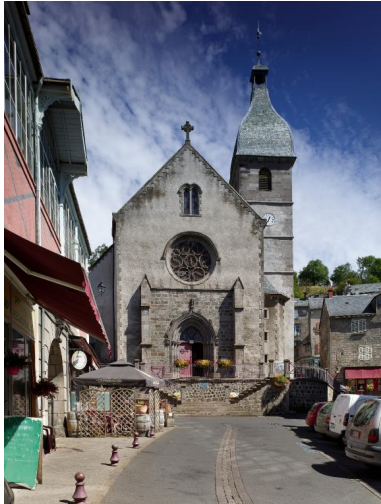
Vue de la façade occidentale Phot. Christian Parisey IVR84_20201500356NUC4A
