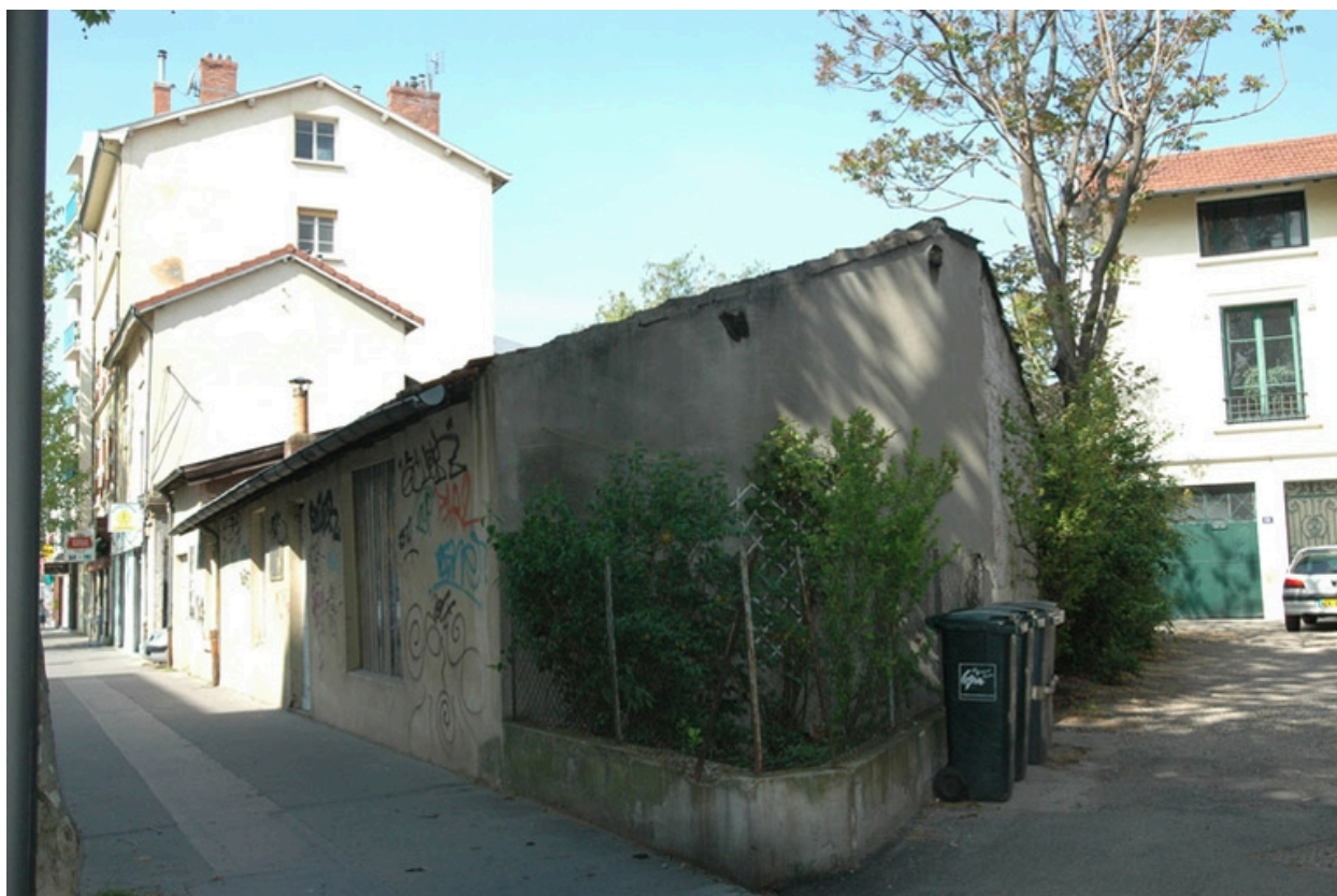
Vue générale, façade principale et angle est.
