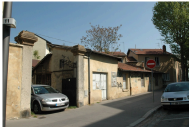
Façade principale, vue sud ouest. Phot. Nadine Halitim-Dubois IVR82_20096901777NUCA
