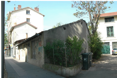
Vue générale, façade principale et angle est. Phot. Nadine Halitim-Dubois IVR82_20096901780NUCA
