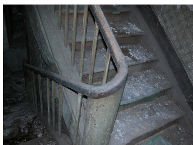
Vue de l'escalier. Phot. Caroline Guibaud IVR82_20134202808NUCA
