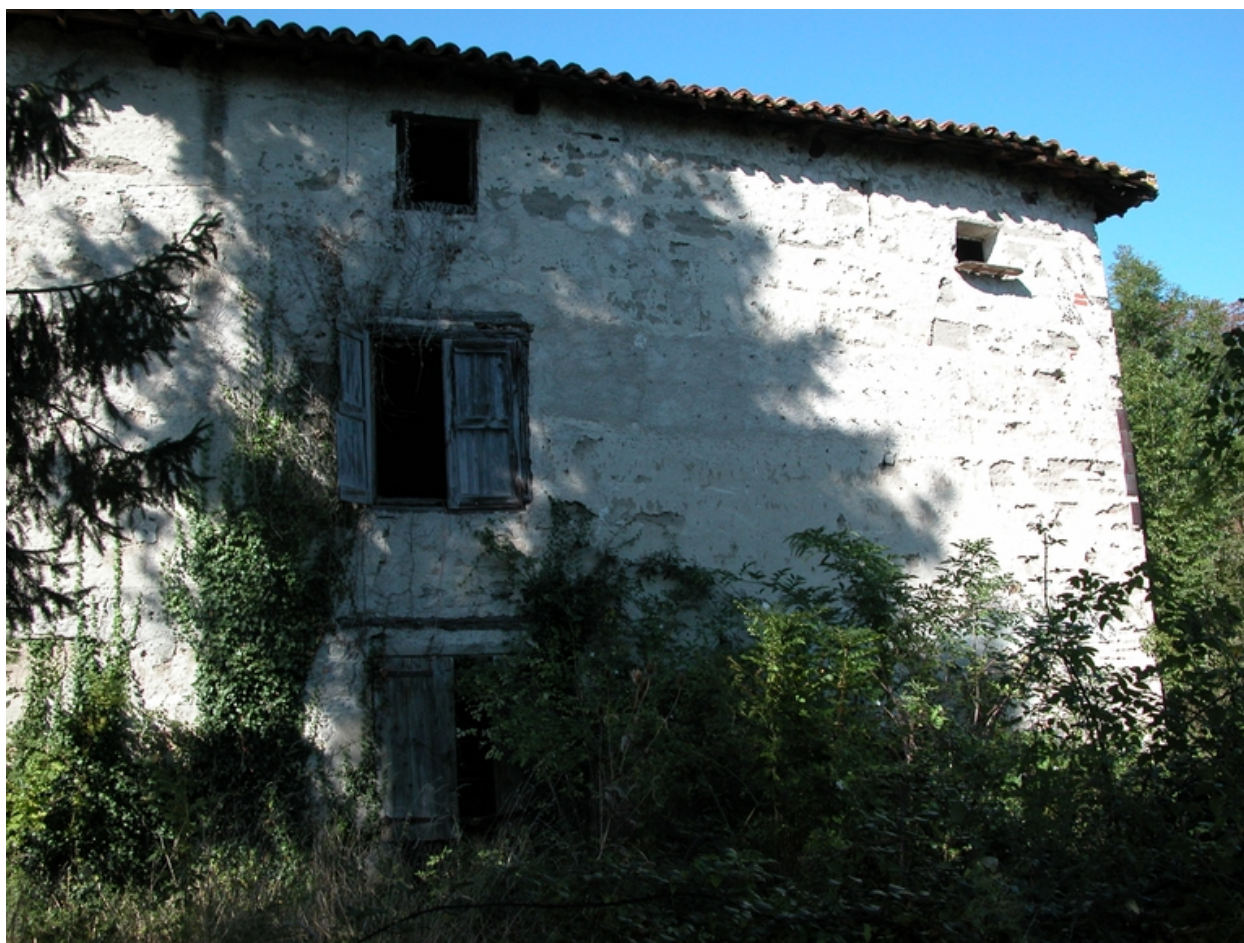
Vue de la façade sur cour, partie nord.
