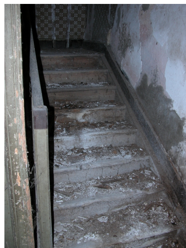
Vue de l'escalier. Phot. Caroline Guibaud IVR82_20134202801NUCA
