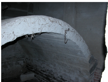
Vue intérieure du rez-de- chaussée : cellier voûté. Phot. Thierry Monnet IVR82_20134202805NUCA
