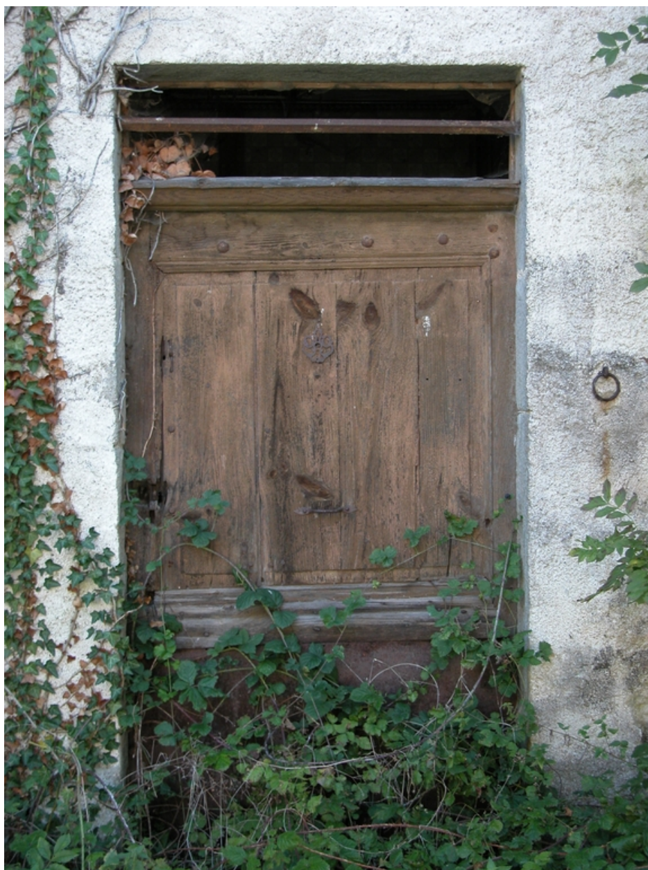
Détail de la porte d'entrée côté chemin.
