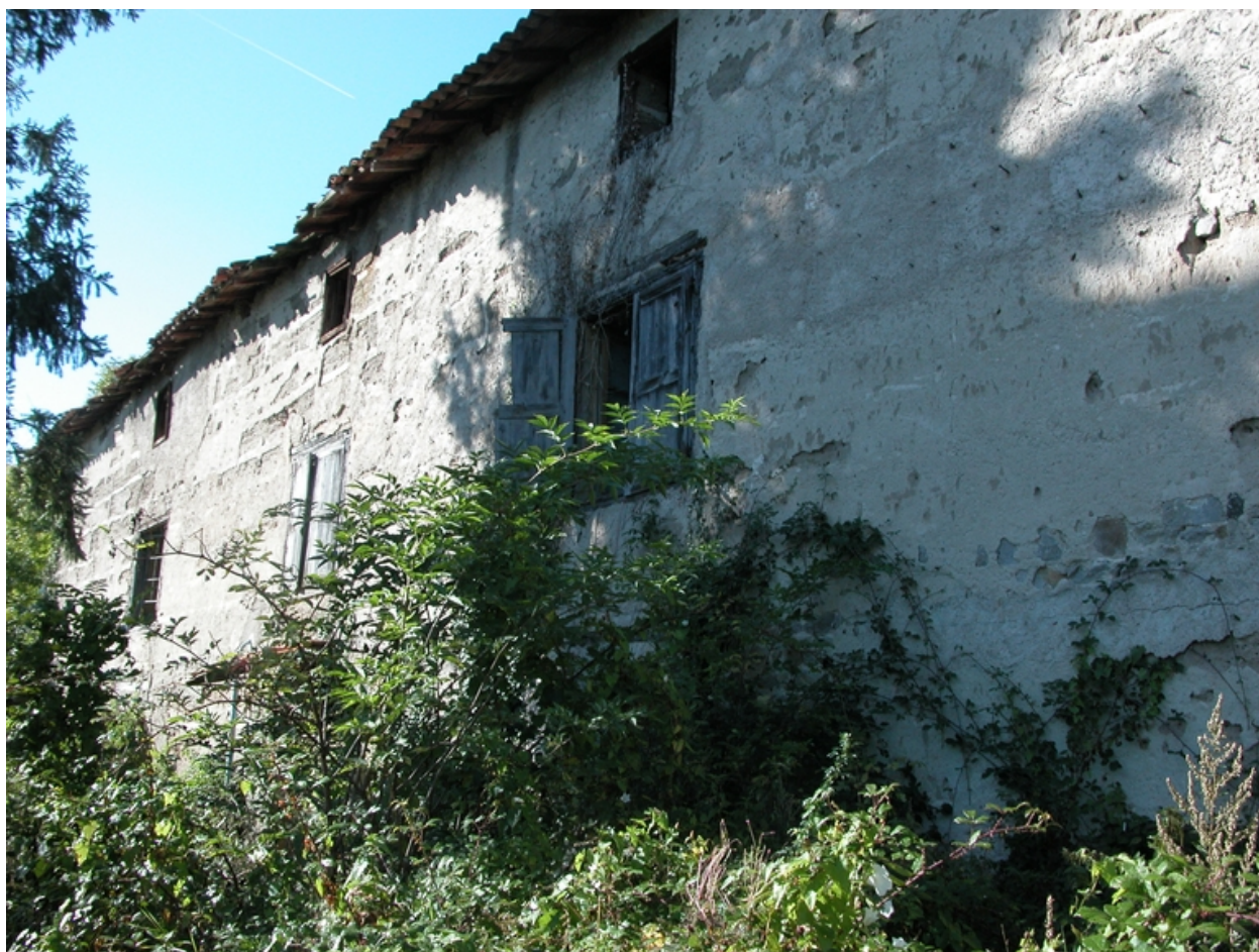
Vue d'ensemble de la façade sur cour.
