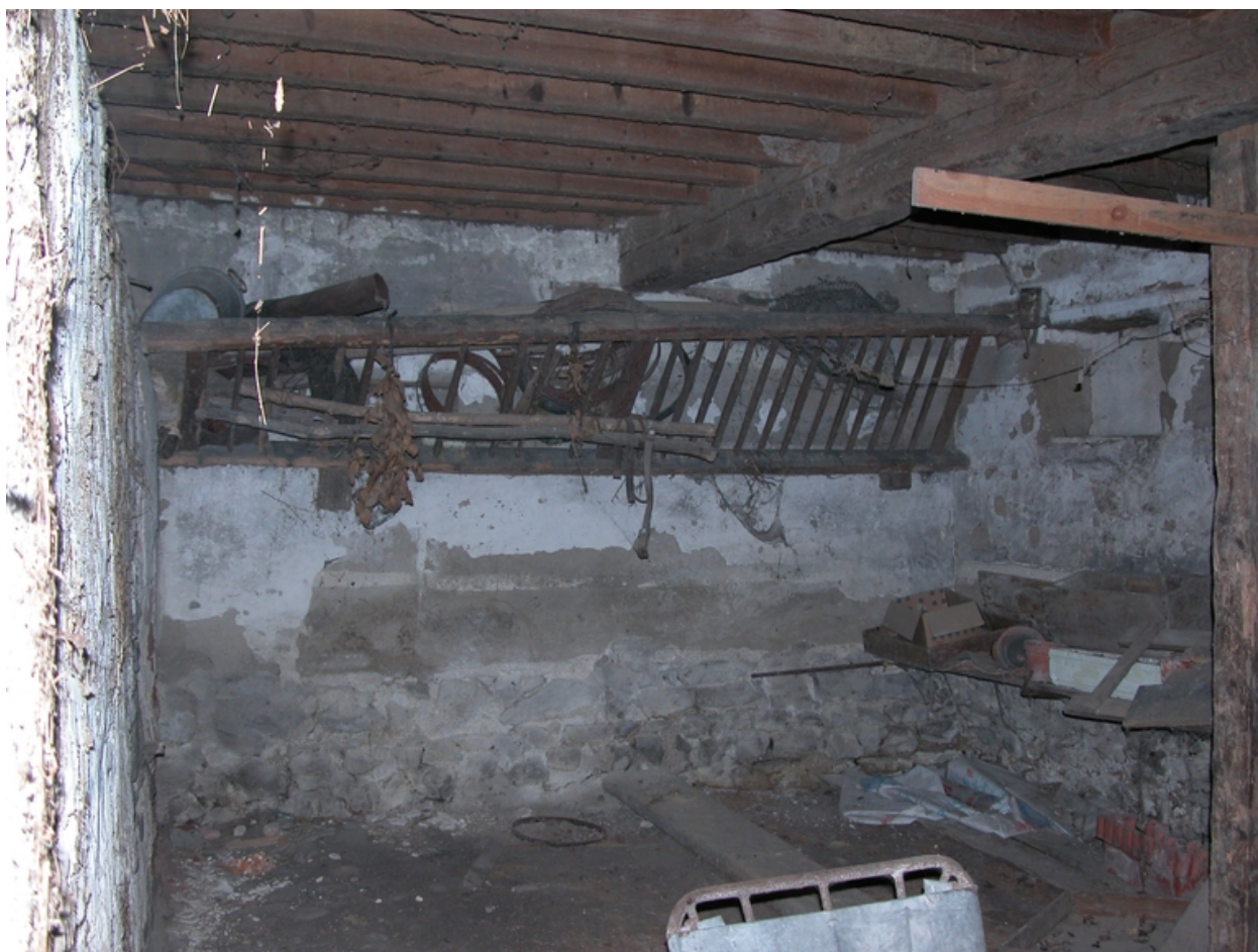
Vue intérieure du rez-de-chaussée : étable sud.
