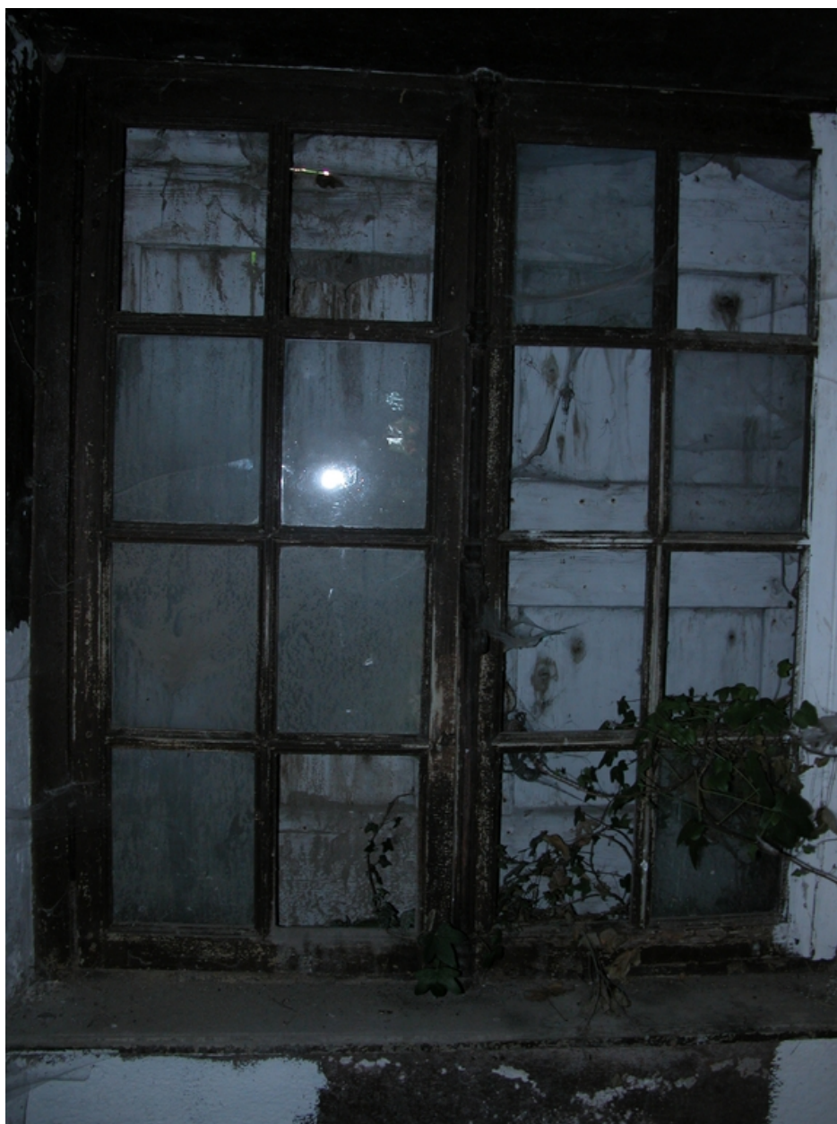
Détail d'une fenêtre, vue de l'intérieur.
