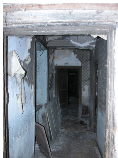
Vue intérieure du rez-de-chaussée : couloir.
