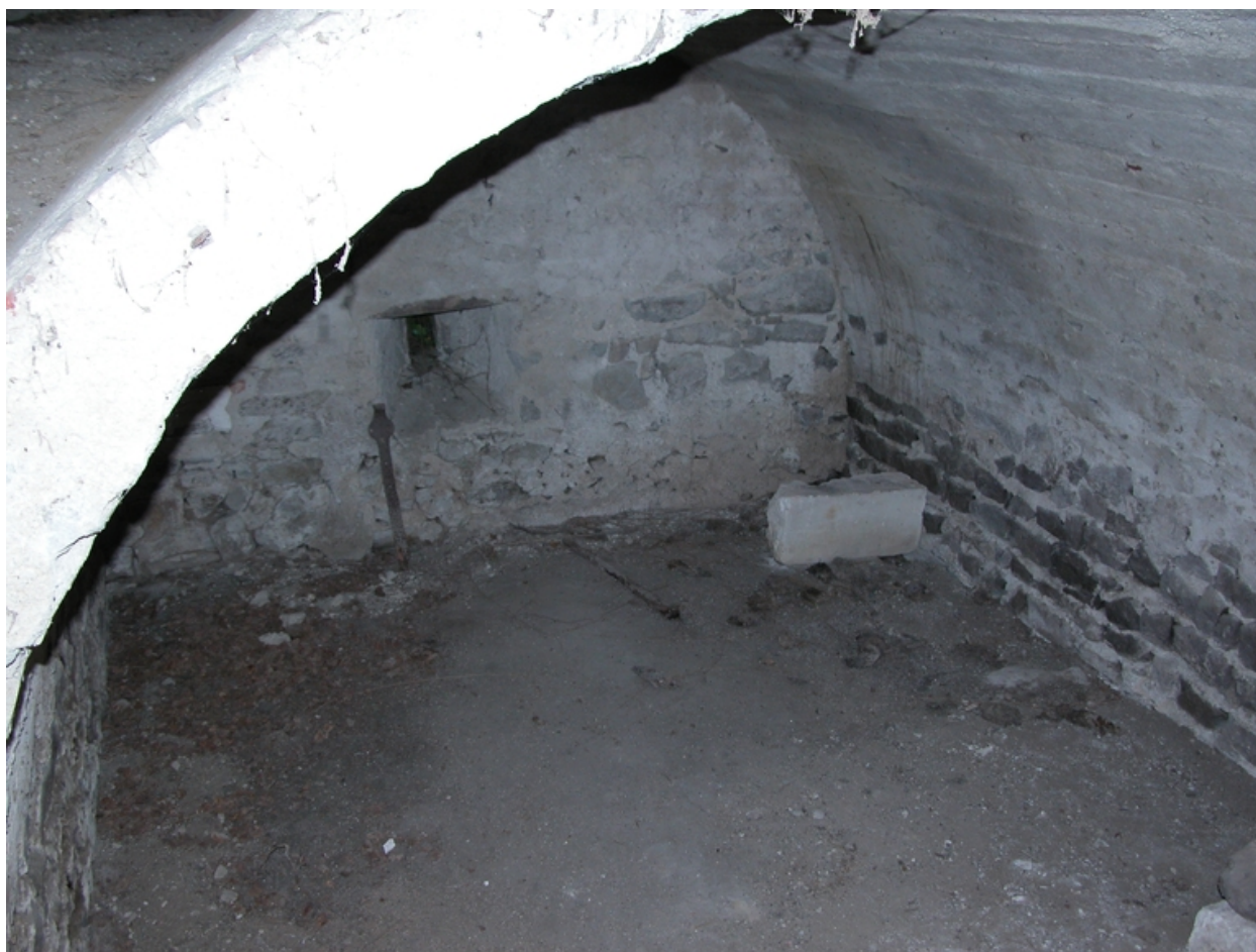
Vue intérieure du rez-de-chaussée : cellier voûté.
