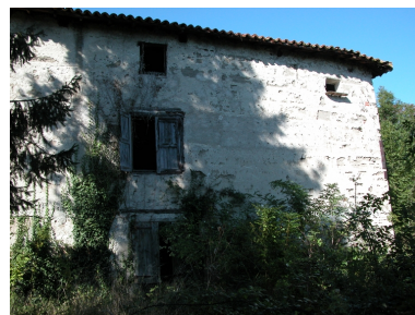
Vue de la façade sur cour, partie nord. Phot. Caroline Guibaud IVR82_20134202811NUCA
