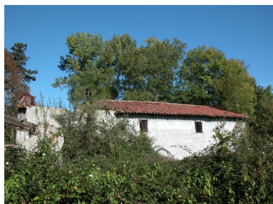
Vue de la grange-étable, depuis la cour. Phot. Caroline Guibaud IVR82_20134202815NUCA
