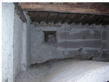
Vue intérieure du rez-de-chaussée : cellier voûté. Phot. Thierry Monnet IVR82_20134202806NUCA
