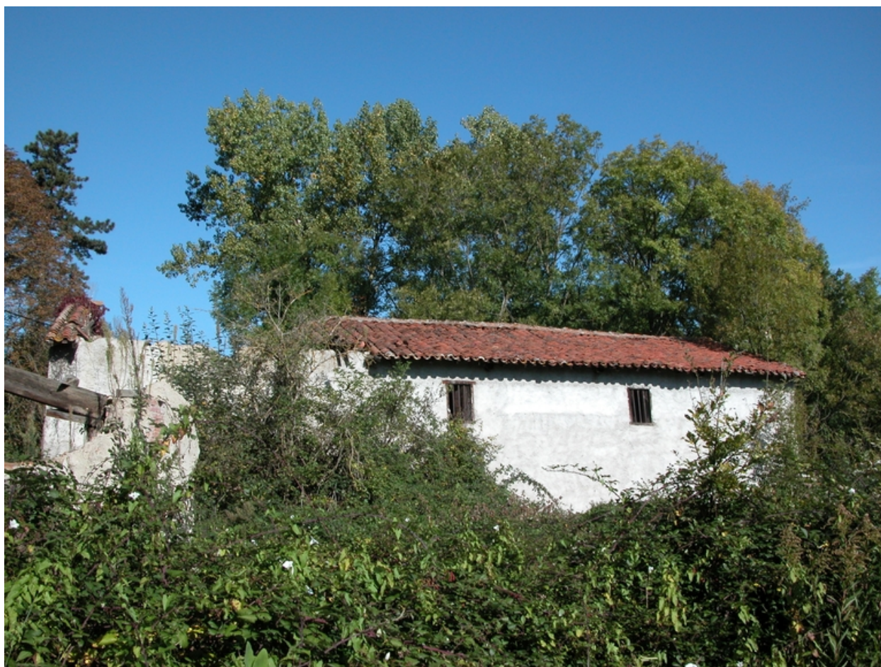
Vue de la grange-étable, depuis la cour.
