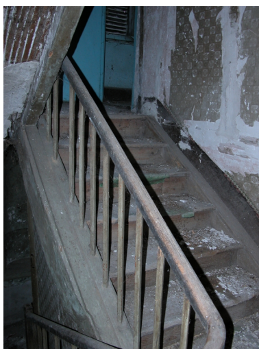
Vue de l'escalier. Phot. Caroline Guibaud IVR82_20134202809NUCA
