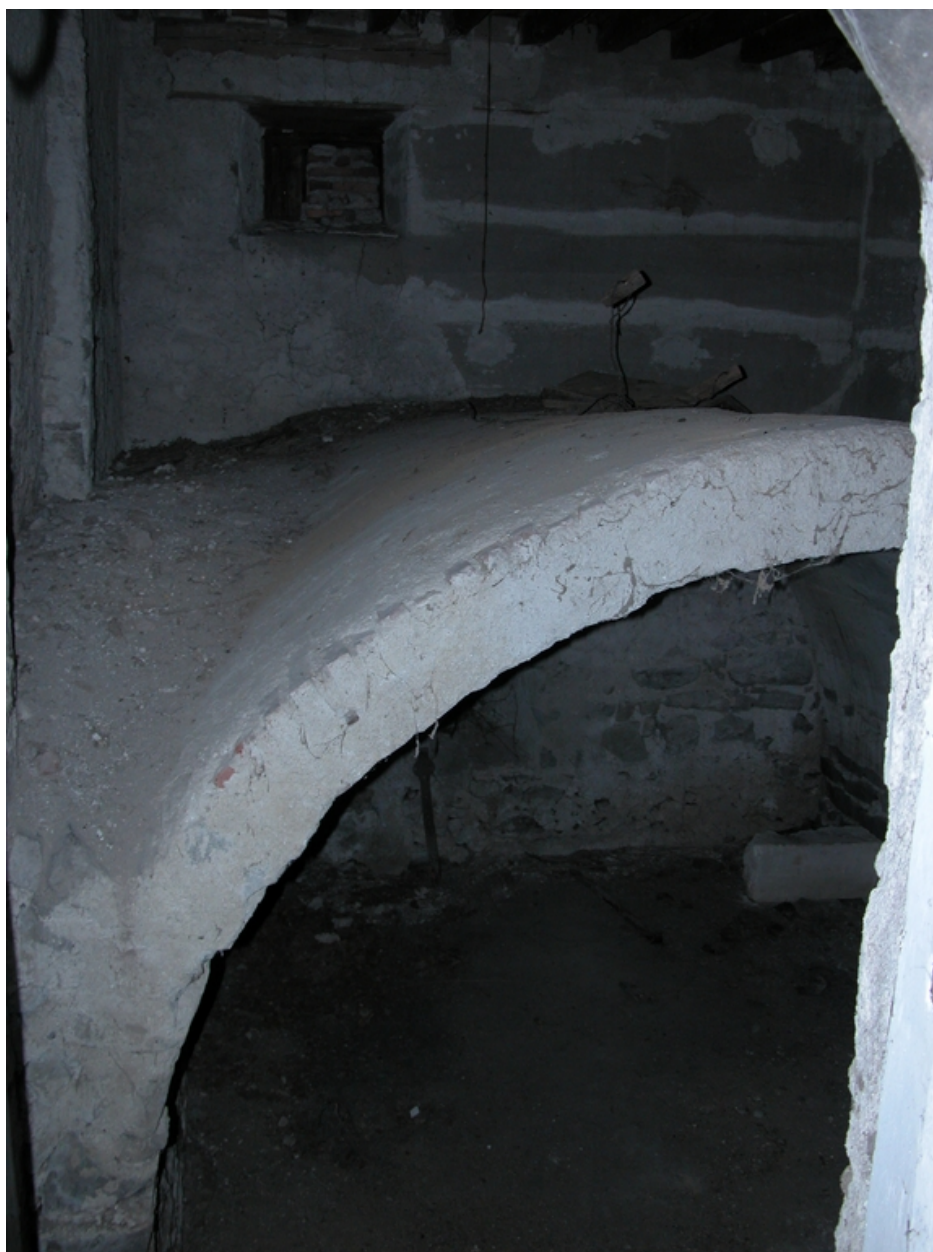
Vue intérieure du rez-de-chaussée : cellier voûté.
