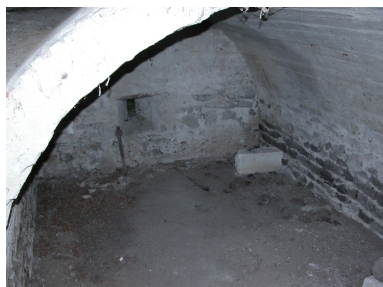
Vue intérieure du rez-de- chaussée : cellier voûté. Phot. Thierry Monnet IVR82_20134202804NUCA
