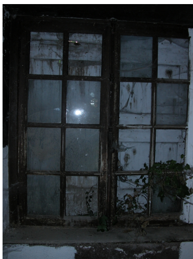
Détail d'une fenêtre, vue de l'intérieur. Phot. Caroline Guibaud IVR82_20134202807NUCA
