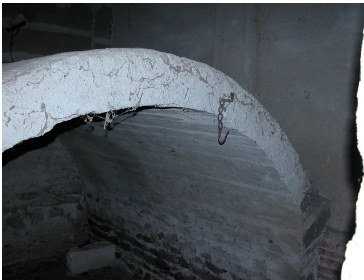
Vue intérieure du rez-de-chaussée : cellier voûté.
