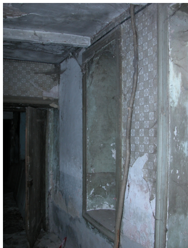
Vue intérieure du rez-de-chaussée : niche dans le mur du couloir. Phot. Caroline Guibaud IVR82_20134202800NUCA
