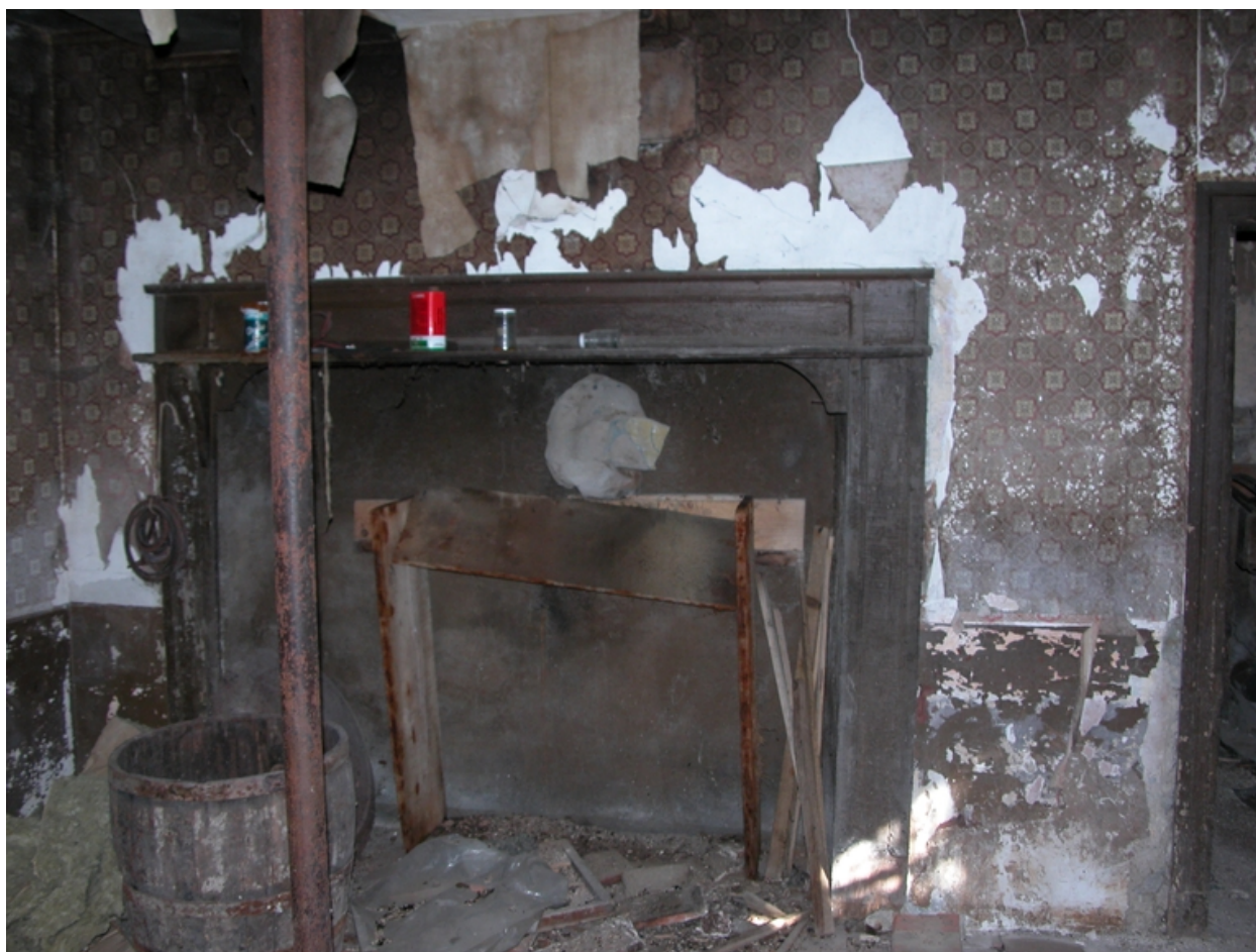
Vue intérieure du rez-de-chaussée : cheminée de la cuisine.
