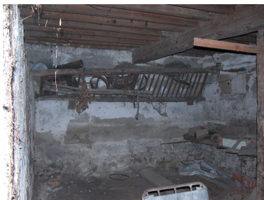
Vue intérieure du rez- de-chaussée : étable sud. Phot. Caroline Guibaud IVR82_20134202798NUCA
