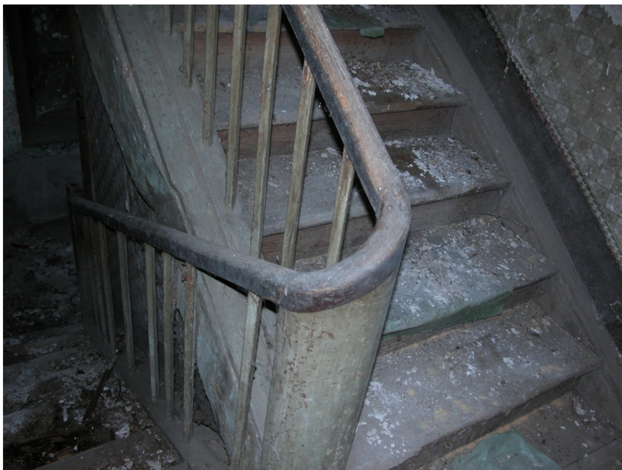
Vue de l'escalier.
