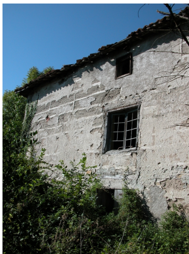
Vue de la façade sur cour, partie sud. Phot. Caroline Guibaud IVR82_20134202812NUCA
