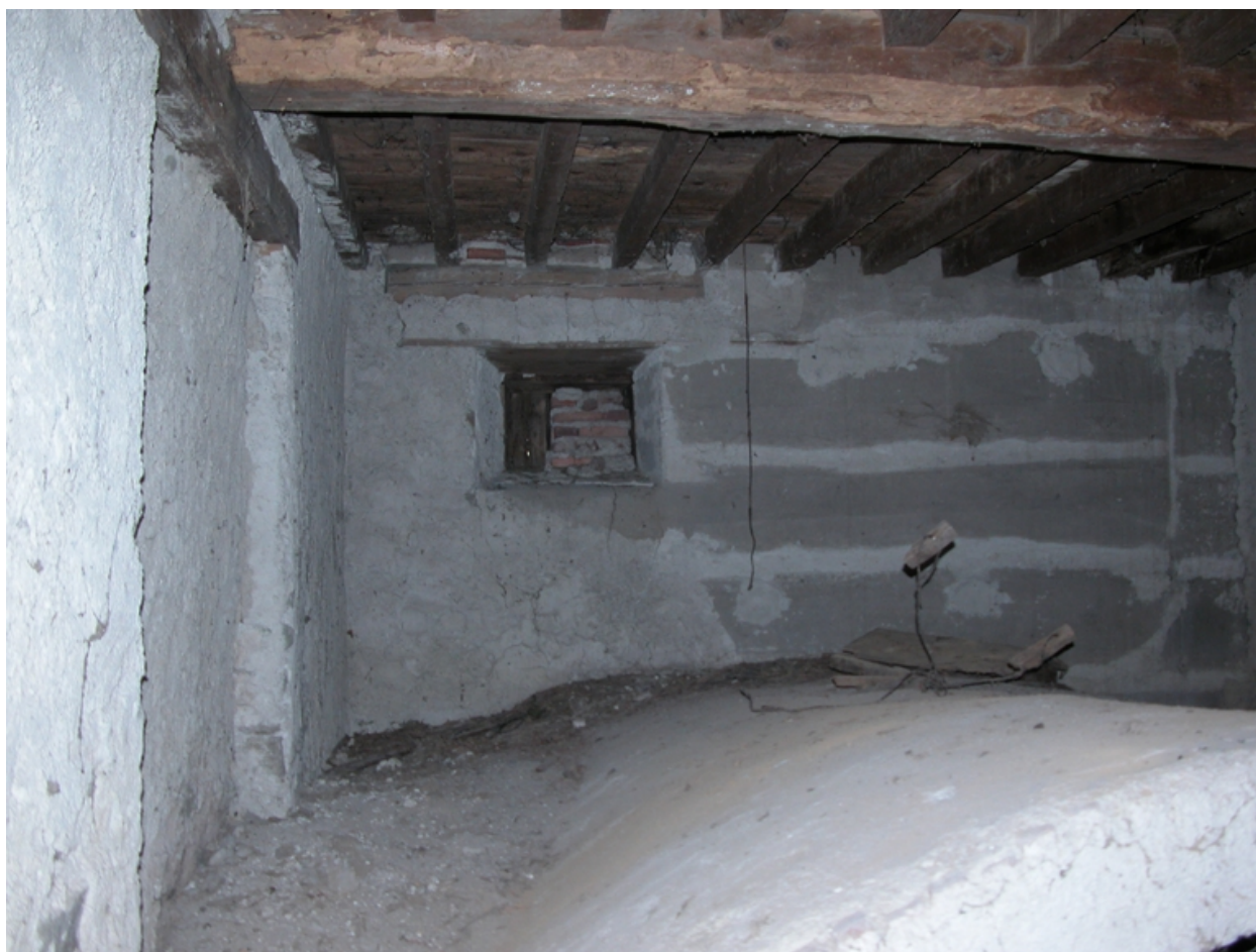
Vue intérieure du rez-de-chaussée : cellier voûté.
