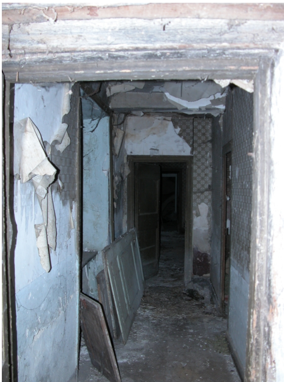
Vue intérieure du rez-de-chaussée : couloir.
