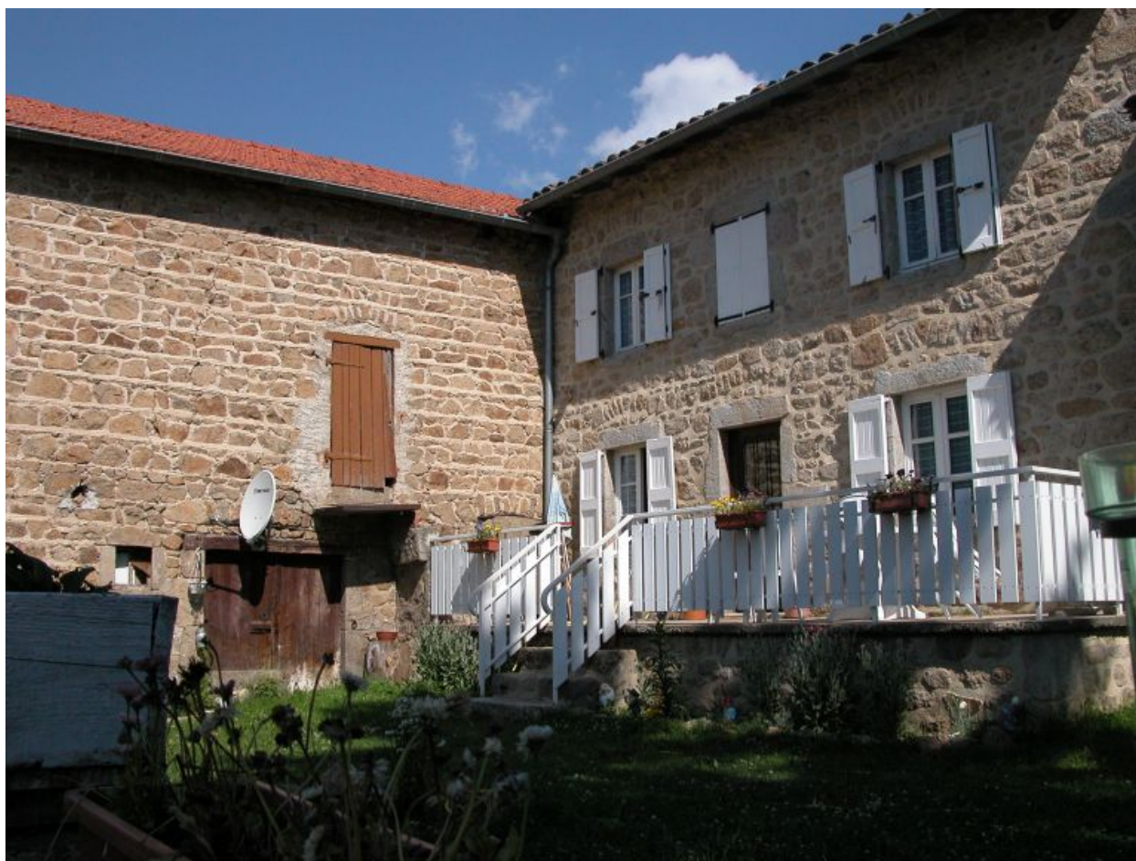
Vue d'ensemble partielle des façades de la ferme sur cour.
