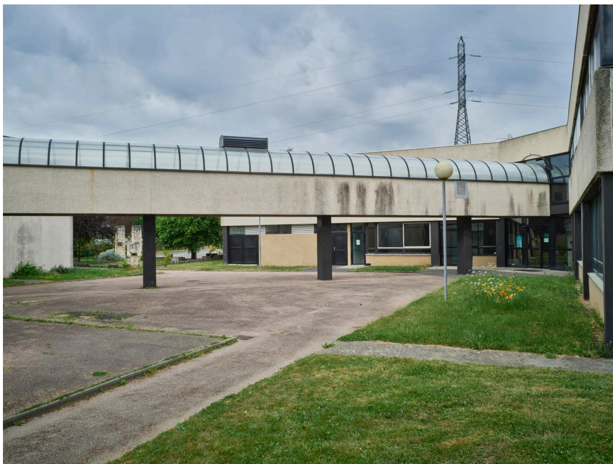
Galerie de liaison entre le bâtiment de l'externat, à gauche, et le bâtiment des ateliers, à droite. L'élément principal de l'oeuvre de Pierre Marion est visible à l'arrière-plan.
