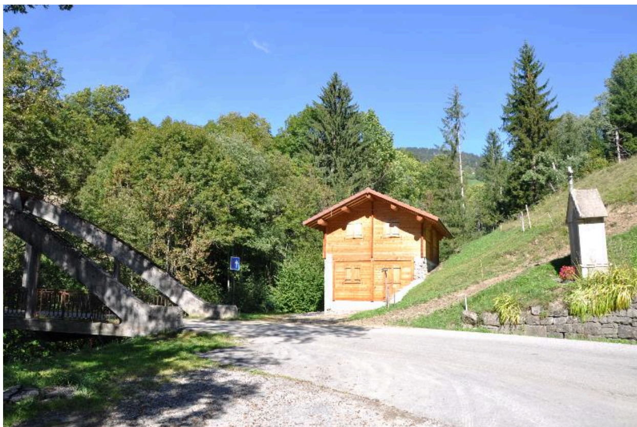
Vue générale des artifices des Choseaux avec au premier plan l'oratoire
