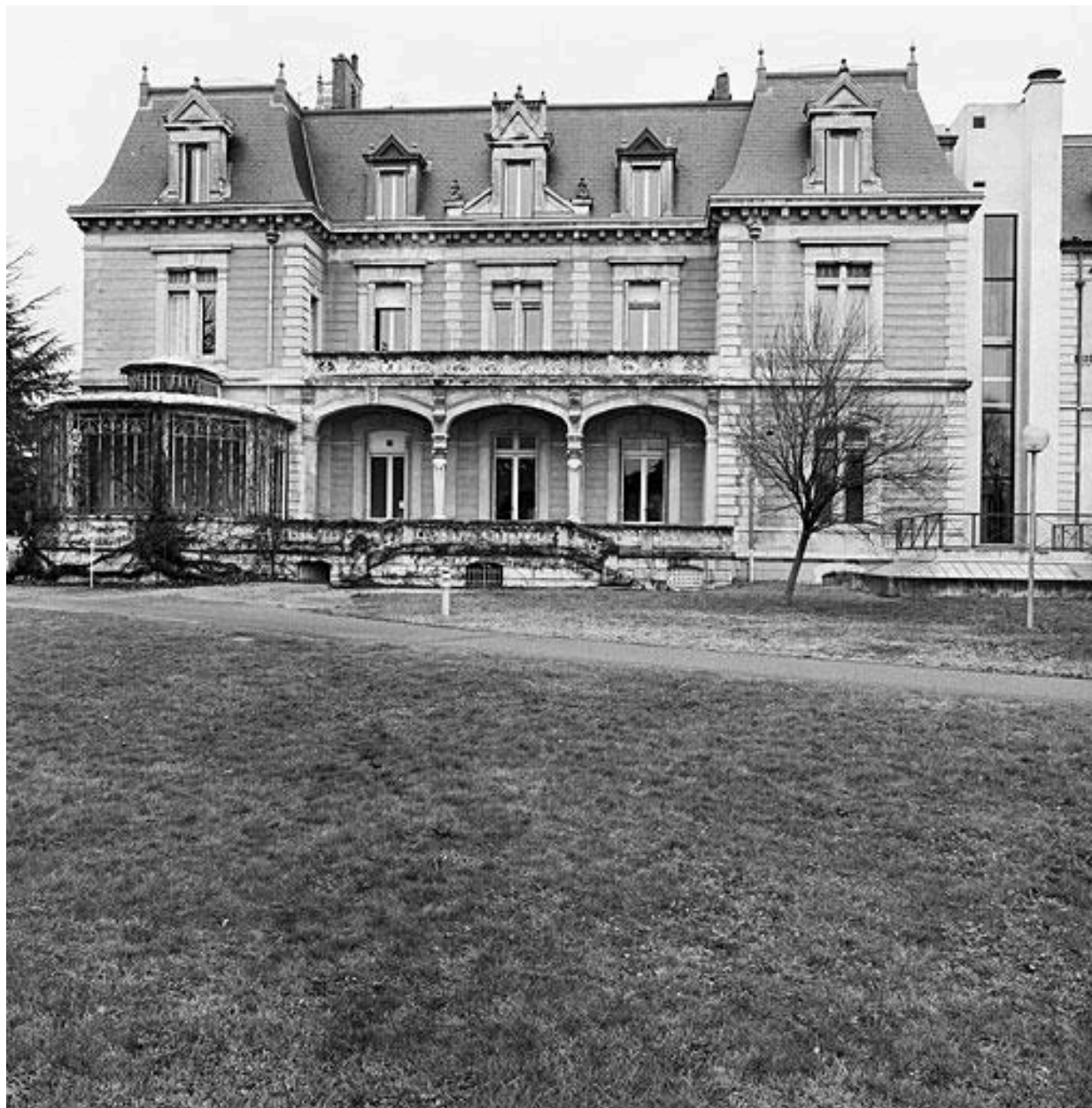
Façade avec galerie côté parc
