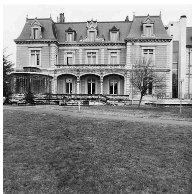
Façade avec galerie côté parc Phot. Martial Couderette IVR82_20042600038X
