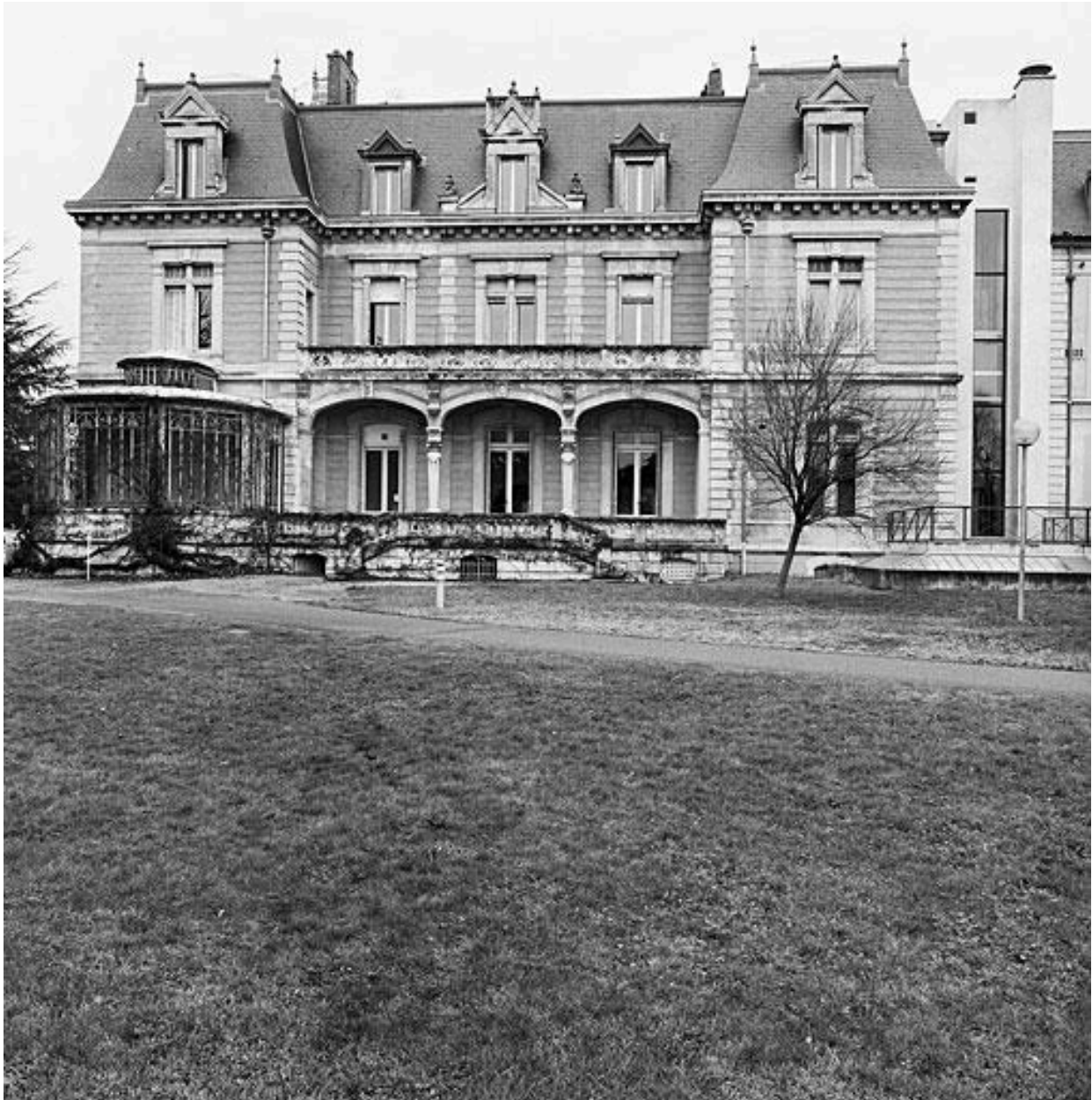
Façade avec galerie côté parc
