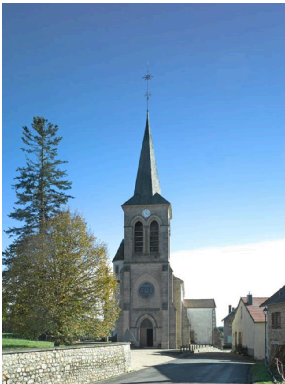
Vue générale de la façade occidentale.
