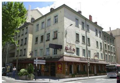
Vue générale depuis l'angle du cours Charlemagne et de la rue Casimir-Perier Phot. François Blanchetière IVR82_20016901977NUCA
