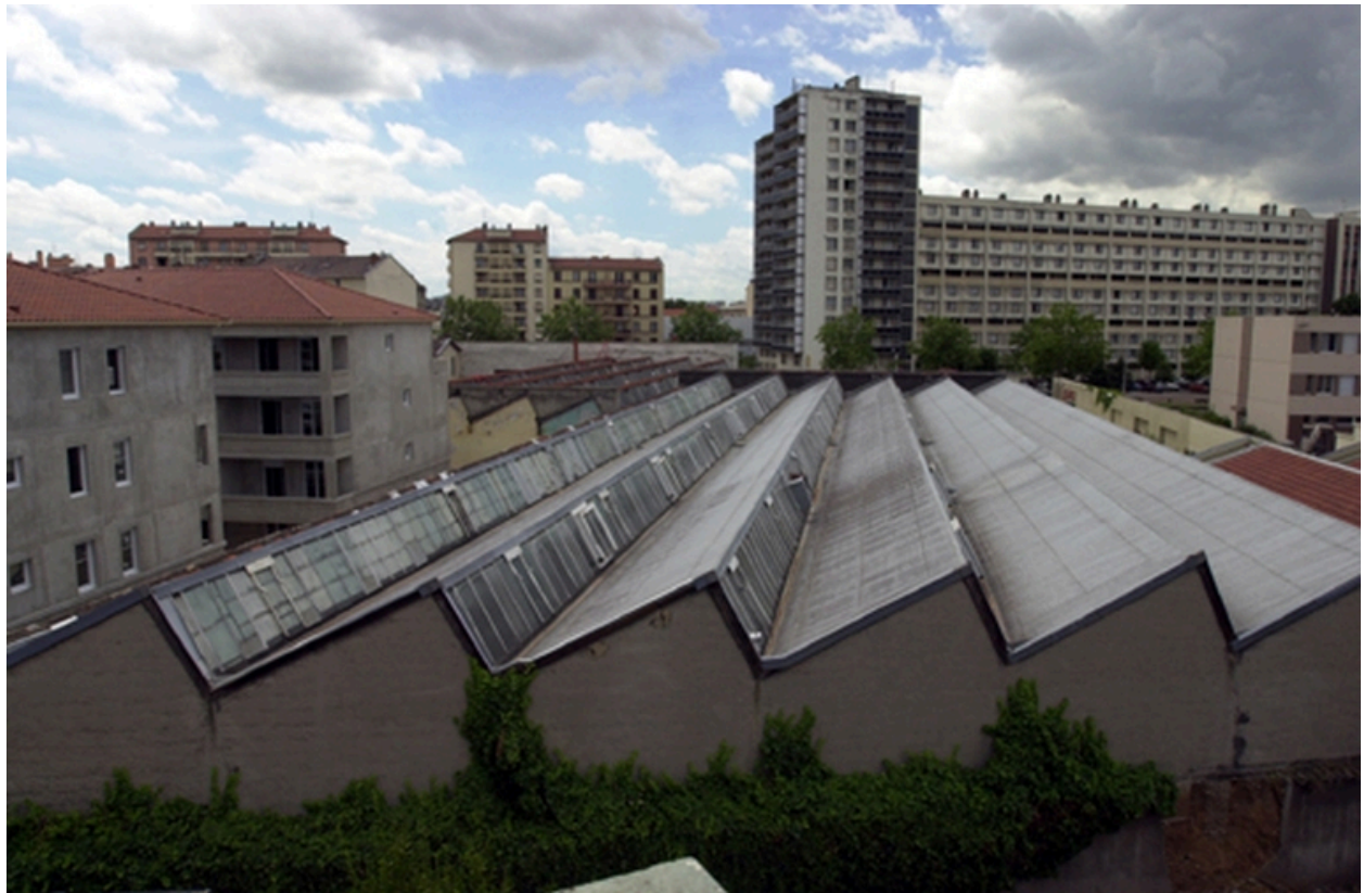
Vue nord zénithale des sheds
