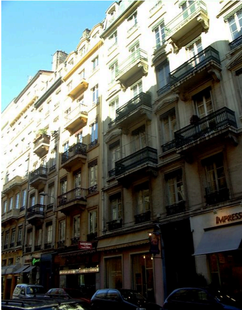
Façade sur rue, vue générale
