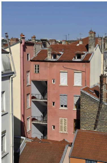
Vue des élévations postérieures Phot. Magali Delavenne IVR82_20156901215NUCA
