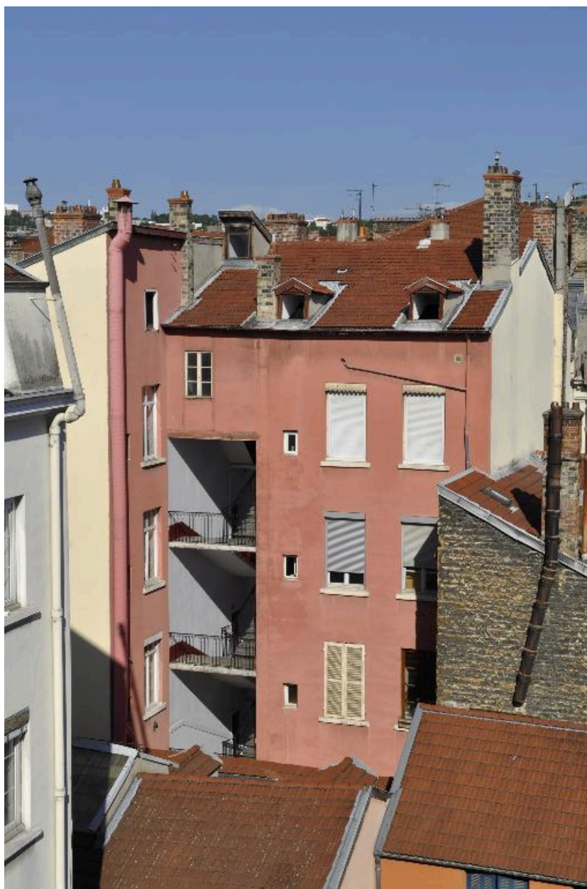
Vue des élévations postérieures
