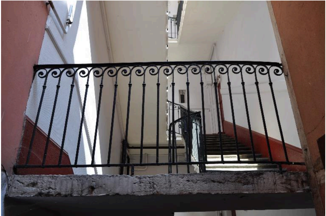
Garde-corps d'un des paliers
