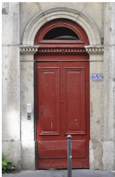
Détail de la porte, tympan en demi-lune Phot. Magali Delavenne IVR82_20156901214NUCA
