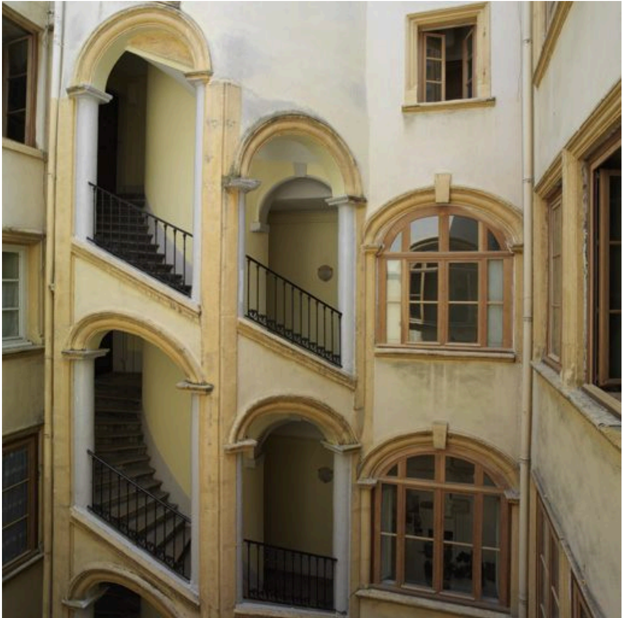
La cage d'escalier depuis le troisième étage de la galerie de liaison
