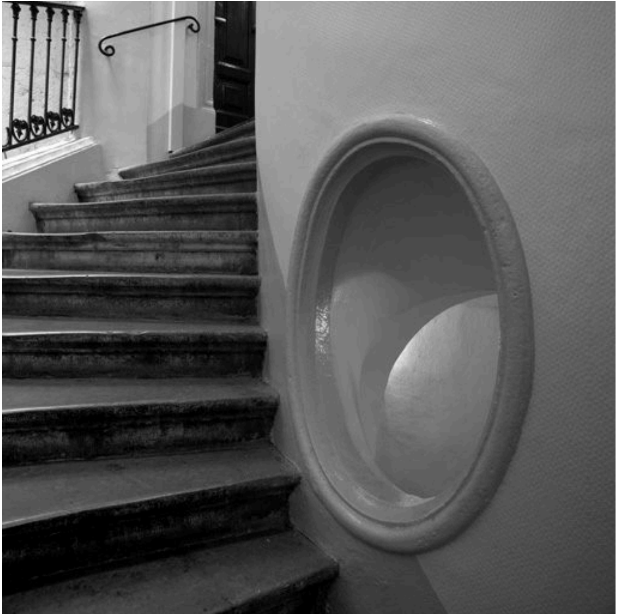
Cage d'escalier, rez-de-chaussée : oculus percé dans le mur noyau
