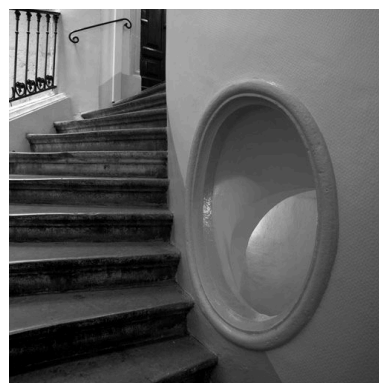
Cage d'escalier, rez-de-chaussée : oculus percé dans le mur noyau Phot. Eric Dessert IVR82_20066900580V
