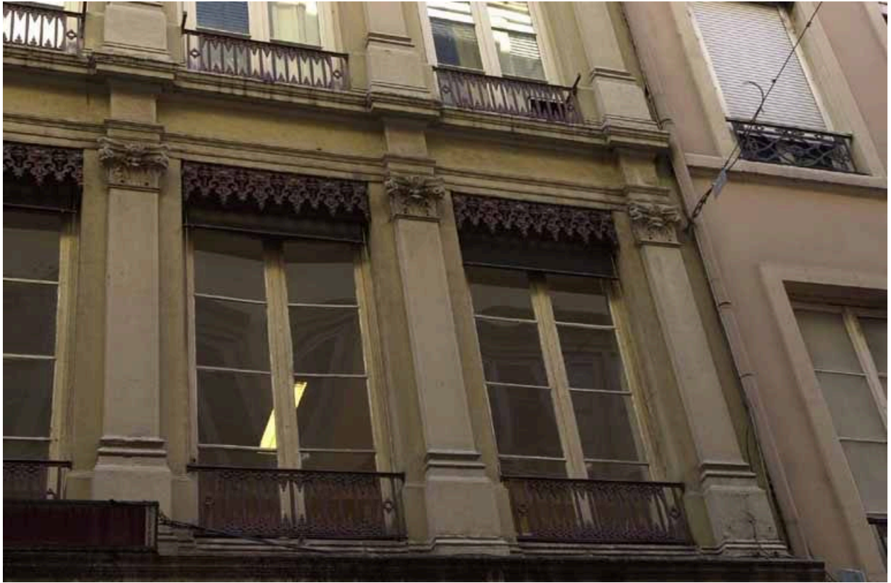
Détail de fenêtres
