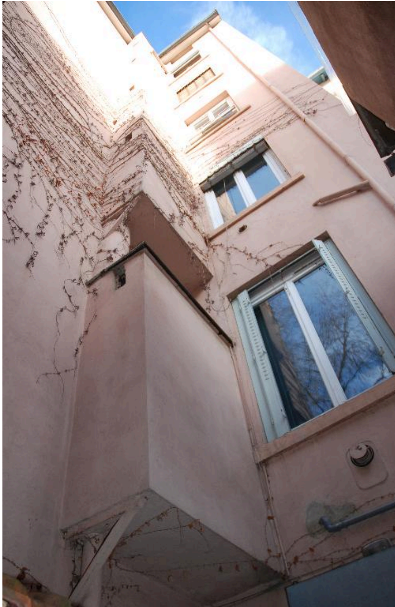
Elévation sur cour : toilettes en encorbellement dans l'angle
