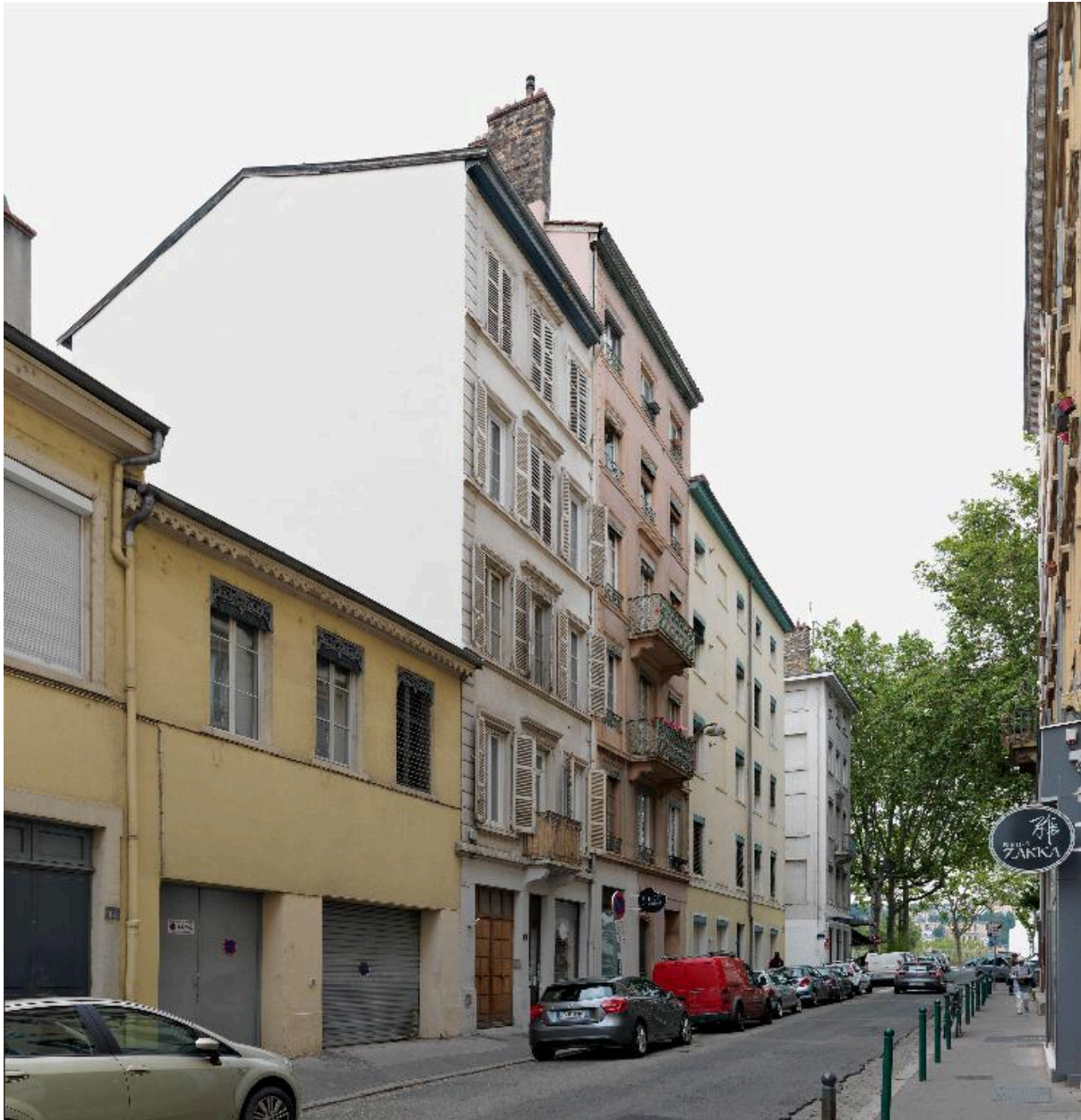
Vue de situation au sein de l'ilot
