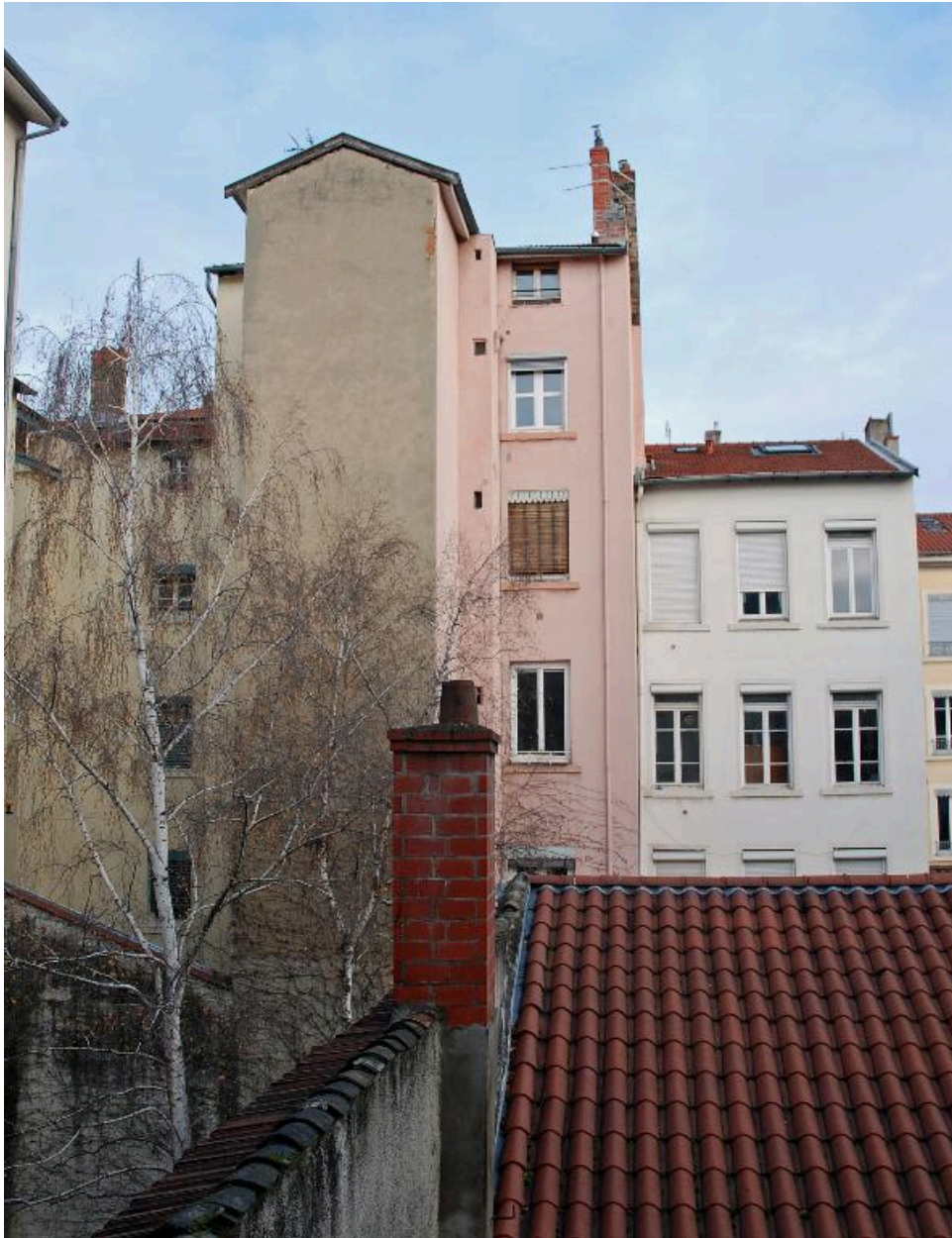
Vue d'ensemble des 8-10 rue d'Aguesseau : élévations sur cour
