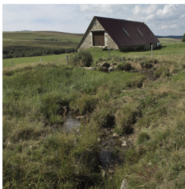
Rigole de circulation d'eau. Phot. Eric Dessert IVR82_20064202072NUCA
