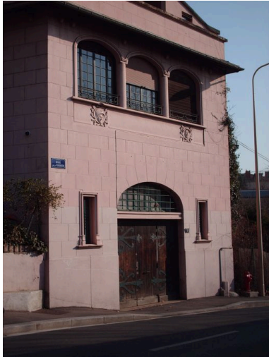
Elévation occidentale Phot. Véronique Belle IVR82_20116902477NUCA
