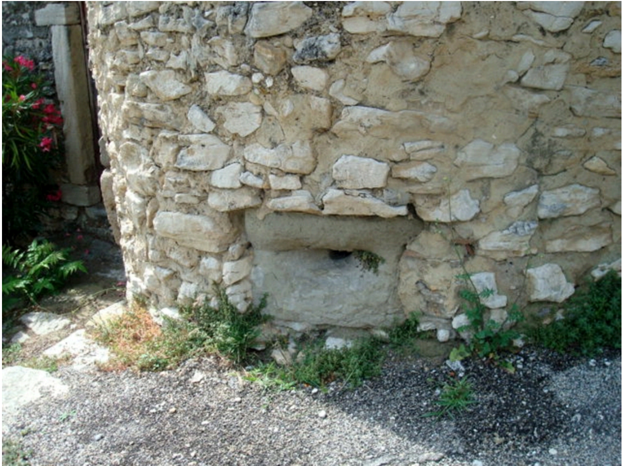
Détail de la tour nord-est : canonnière.
