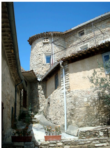
Tour d'angle ouest du castrum, montée de la Viale. Phot. Geneviève Jourdan IVR82_20112600054NUCA
