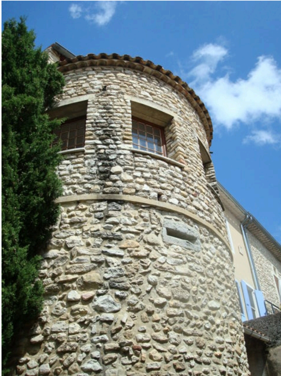
Tour sur le côté sud de la courtine.
