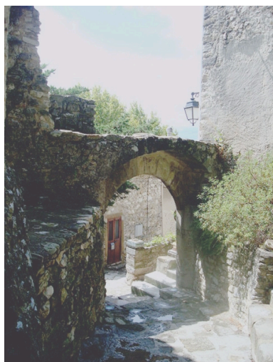
Porte sud-ouest, vue de l'intérieur du castrum. Phot. Geneviève Jourdan IVR82_20112600056NUCA
