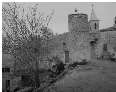
Partie supérieure de la fortification, côté est de l'enceinte, tour nord-est contre l'église.
