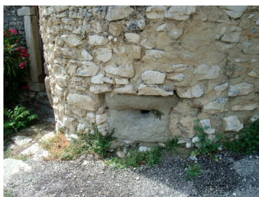
Détail de la tour nord- est : canonnière. Phot. Geneviève Jourdan IVR82_20112600057NUCA
