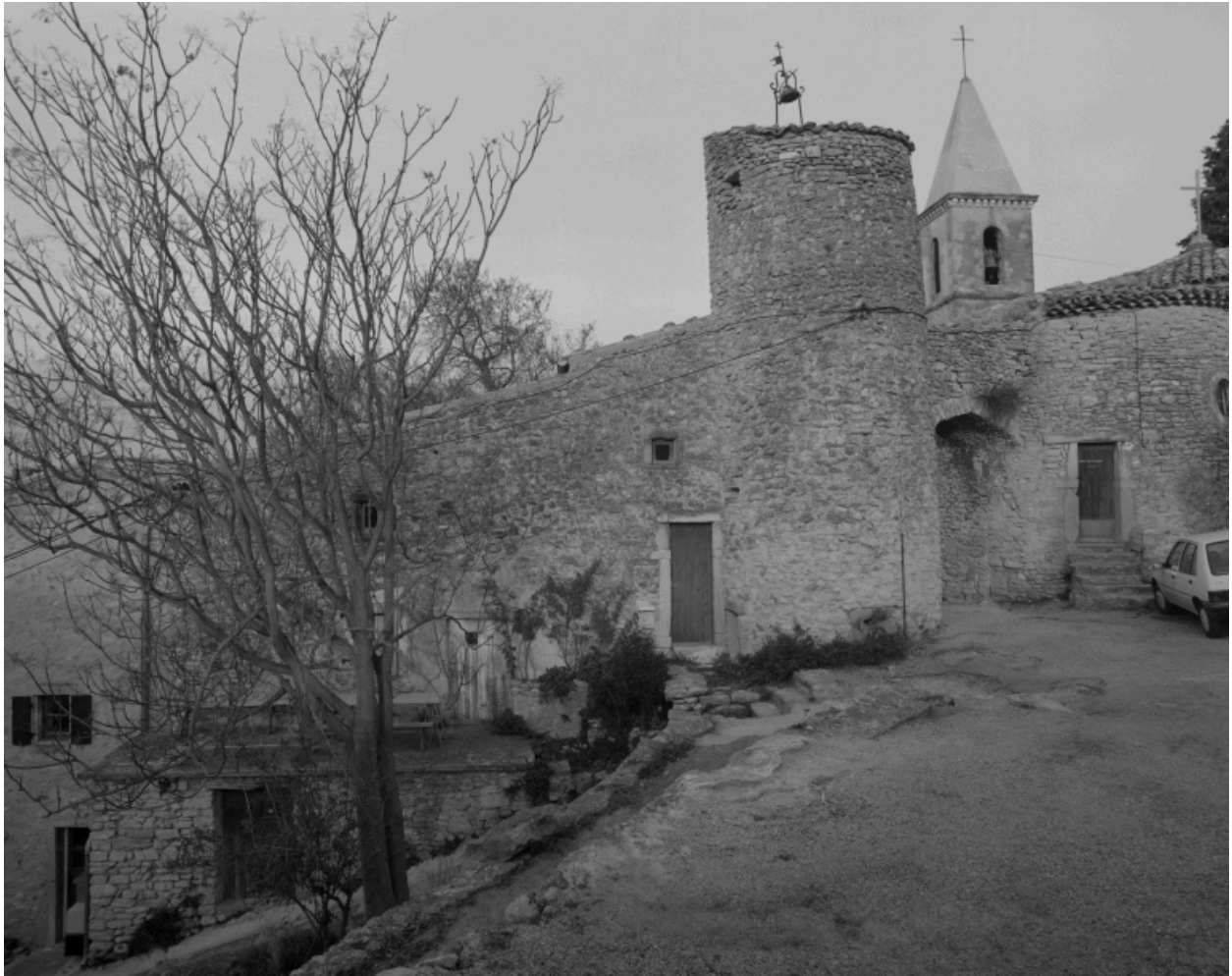
Partie supérieure de la fortification, côté est de l'enceinte, tour nord-est contre l'église.
