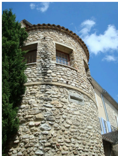
Tour sur le côté sud de la courtime. Phot. Geneviève Jourdan IVR82_20112600058NUCA
