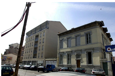
Vue générale Phot. Lore Derail IVR82_20036900452NUCA
