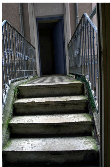
Passerelle desservant le 1er étage Phot. Maryannick Chalabi IVR82_20096901383NUCA
