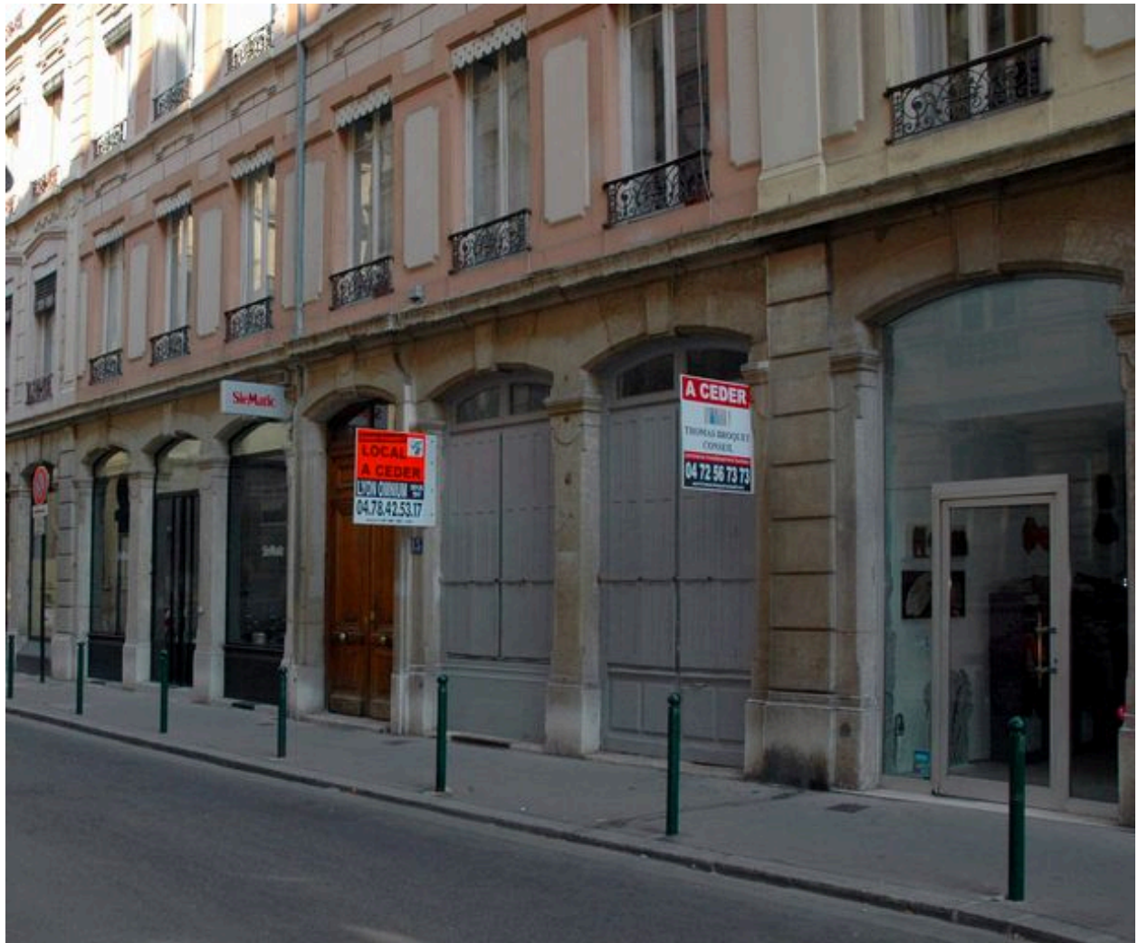
Vue du rez-de-chaussée
