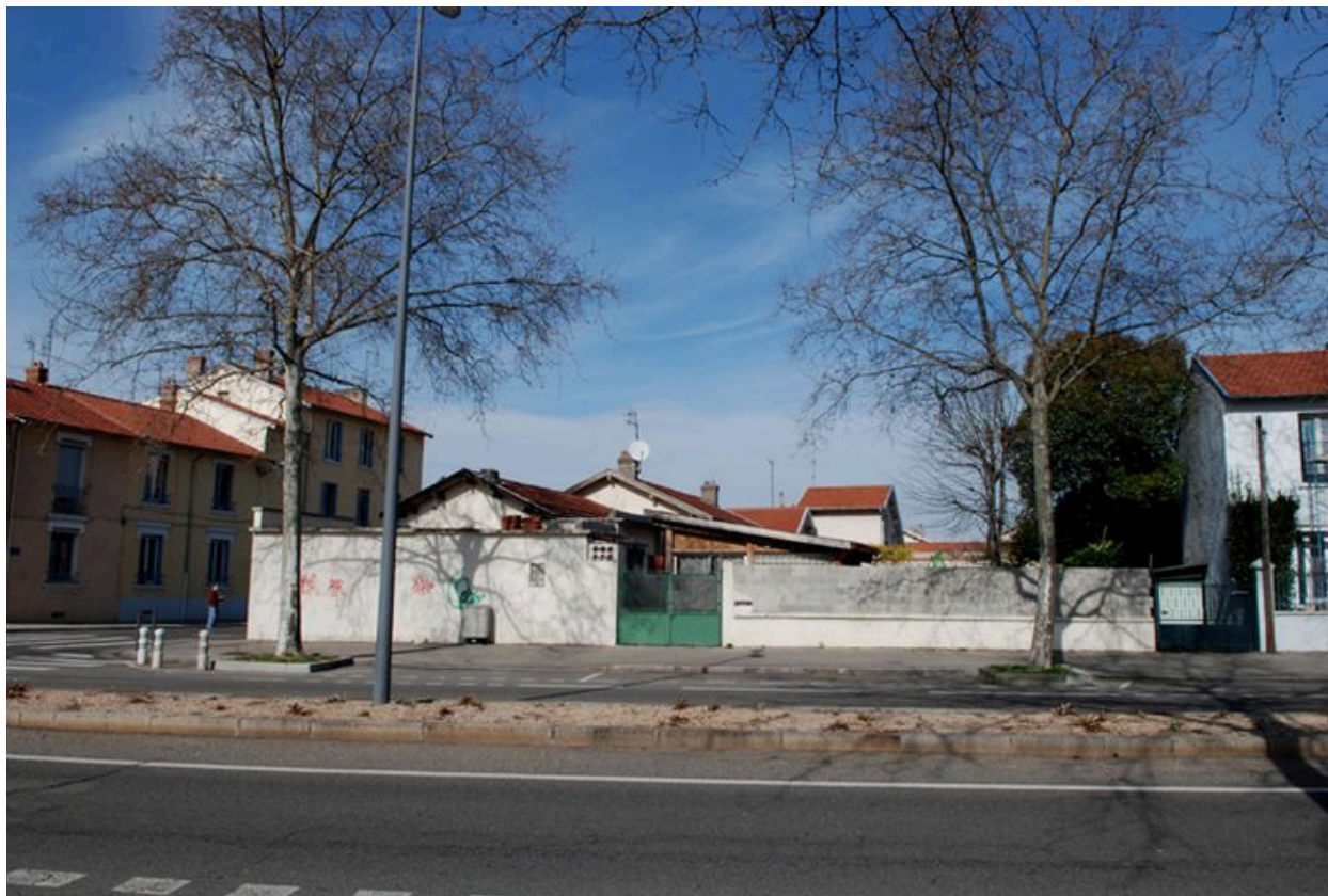
Elévation antérieure, mur de clôture
