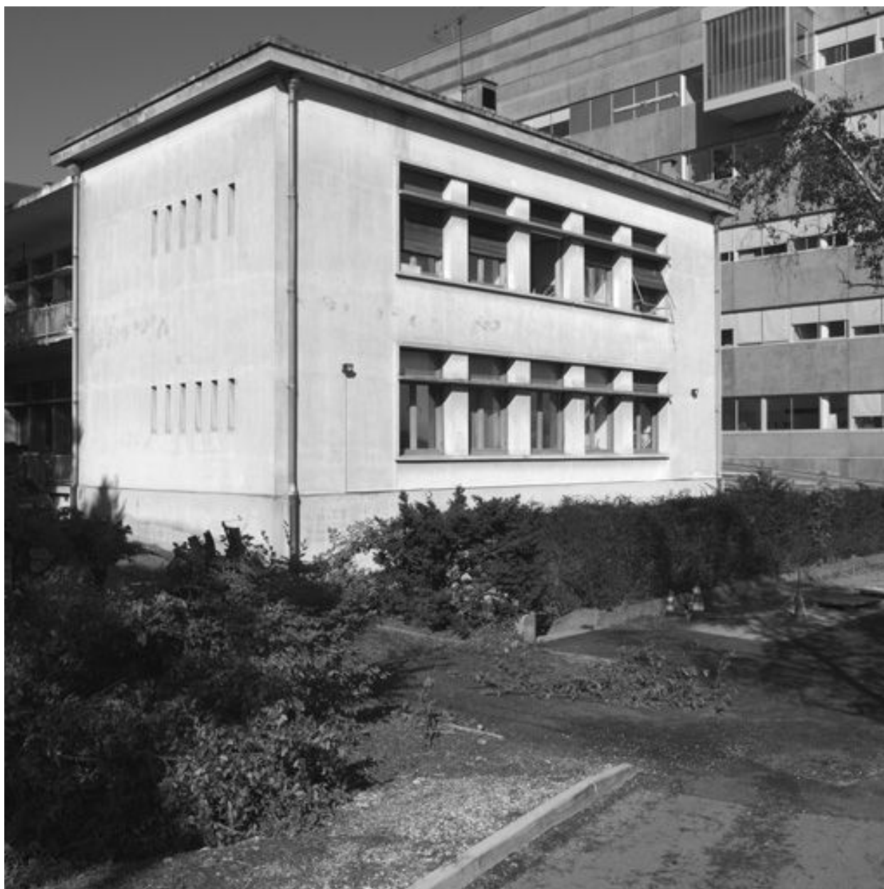
Bâtiment W, extrémité est de l'aile nord
