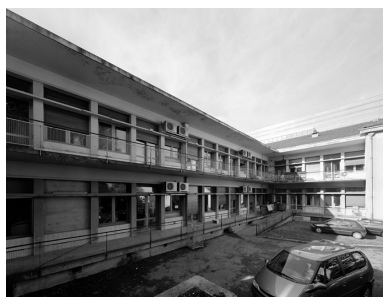
Bâtiment W, élévation sur la cour est Phot. Didier Gourbin IVR82_20046901579V
