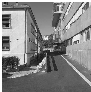
Bâtiment W, aile nord, élévation nord (à gauche) Phot. Didier Gourbin IVR82_20056900335NUC
