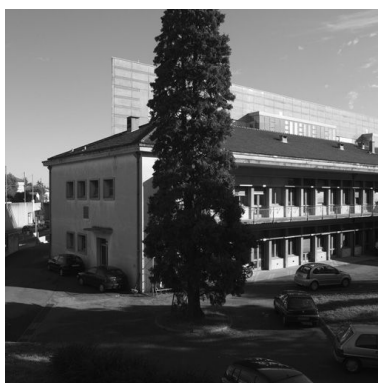
Bâtiment W, aile nord, élévation sur la cour ouest Phot. Didier Gourbin IVR82_20056900324NUC
