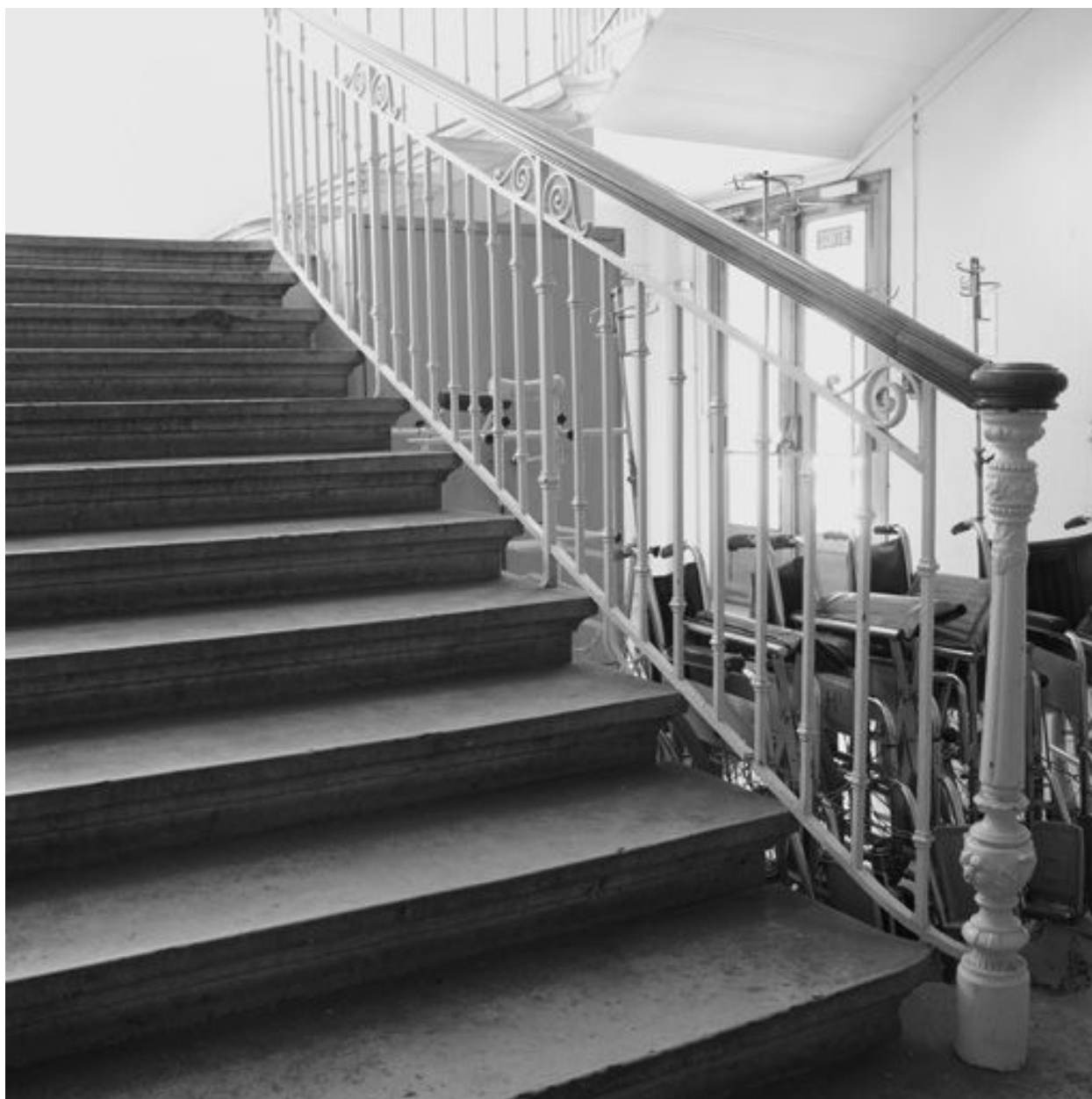
Bâtiment RST, départ de l'escalier au centre de l'aile S
