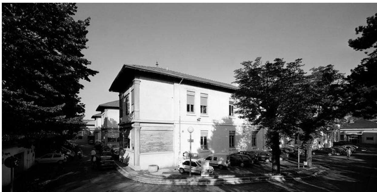
Bâtiment RST, vue générale depuis le côté est des logias aux extrémités des trois ailes
