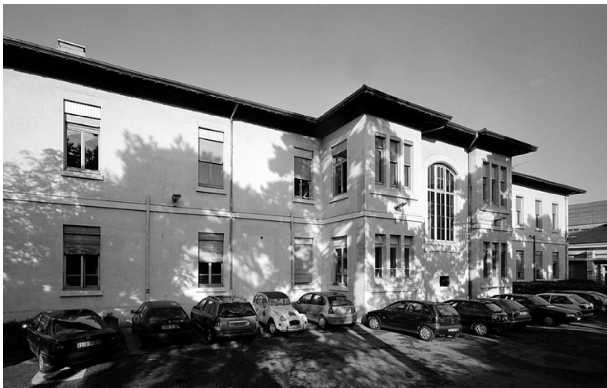
Bâtiment RST, aile T, élévation est
