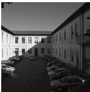
Bâtiment RST, cour au sud entre les ailes S et T Phot. Didier Gourbin IVR82_20056900327NUC
