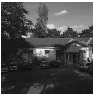
Bâtiment V, aile ouest Phot. Didier Gourbin IVR82_20056900341NUC
