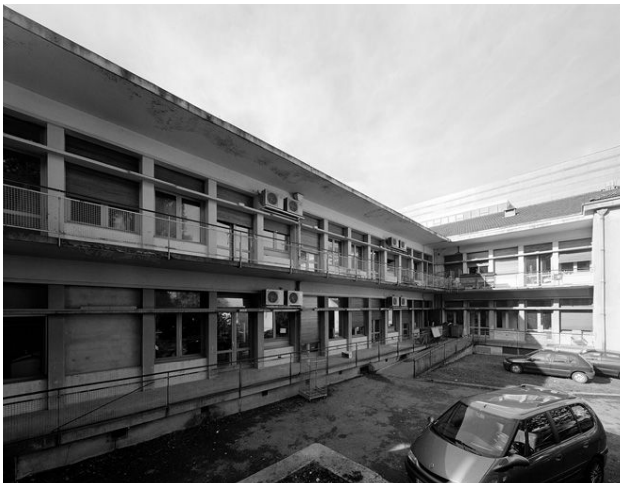
Bâtiment W, élévation sur la cour est
