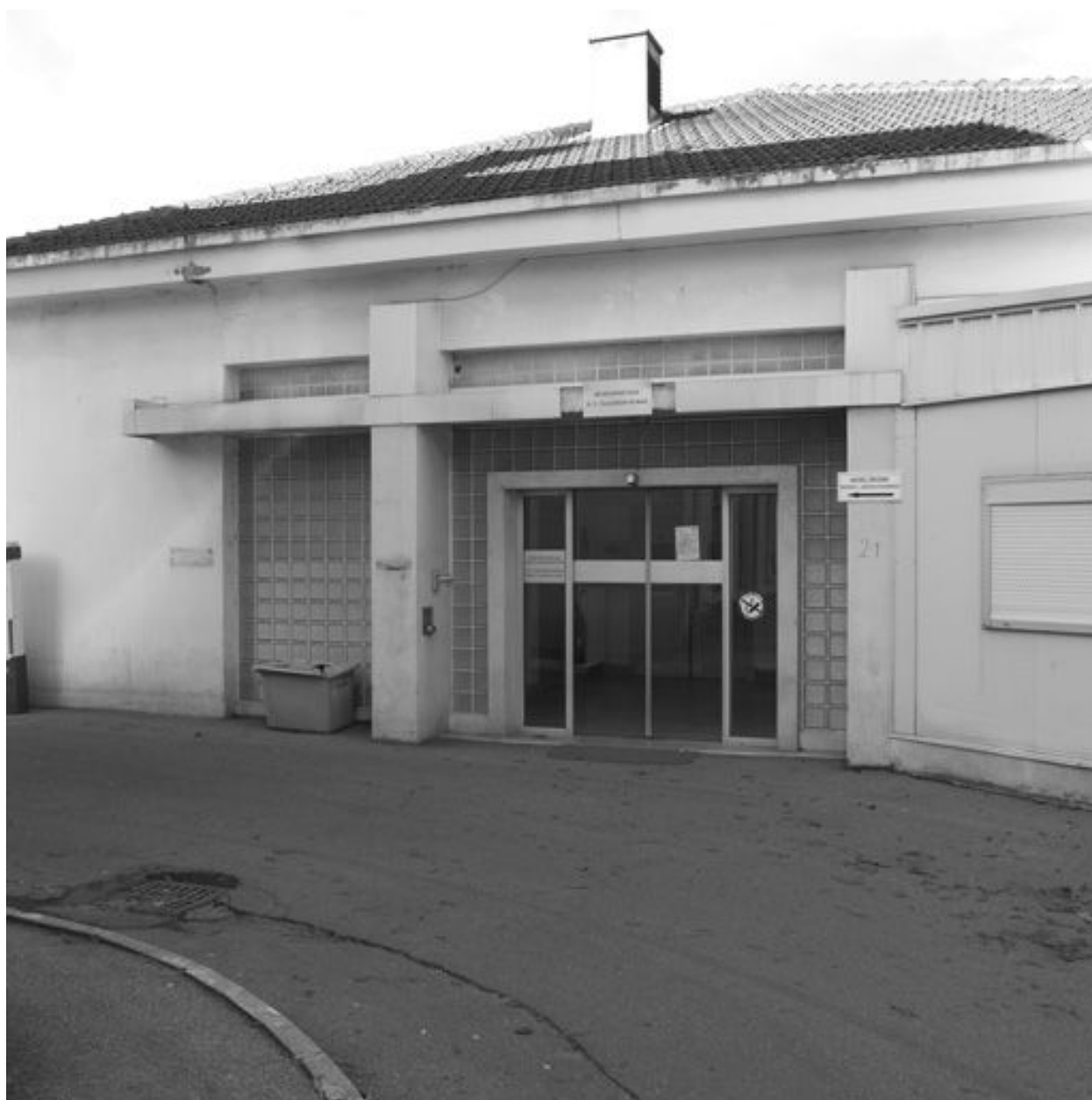
Bâtiment W, entrée principale au sud
