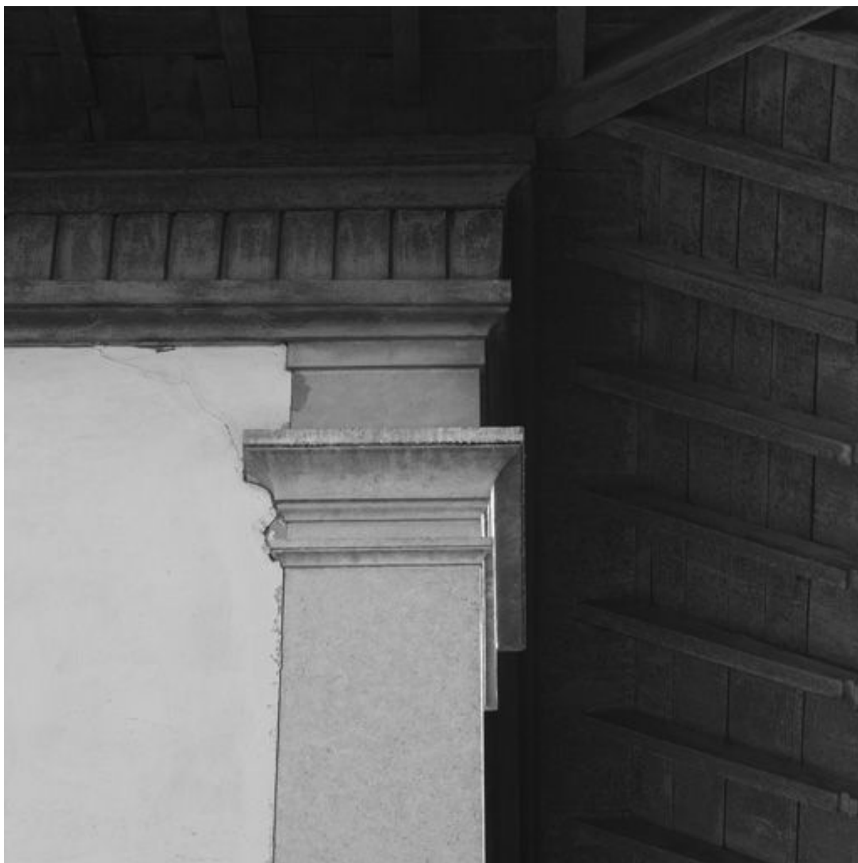
Bâtiment RST, aile T, extrémité sud, détail d'un pilier d'angle de l'ancienne loggia du 1er étage
