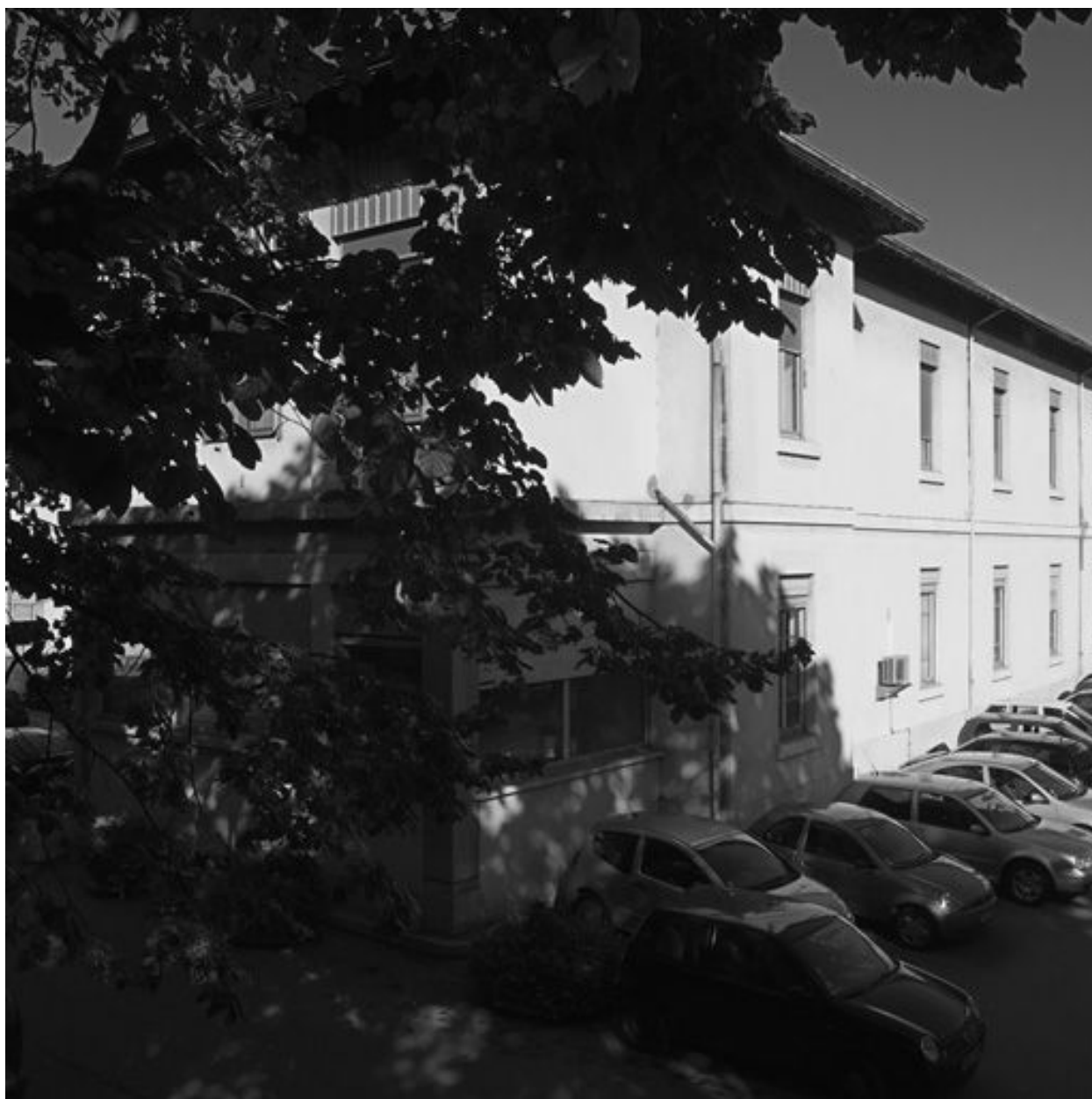
Bâtiment RST, aile S, extrémité nord
