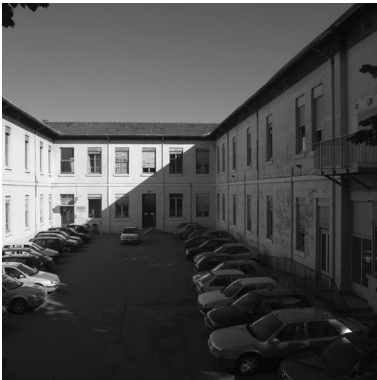
Bâtiment RST, cour au sud entre les ailes S et T
