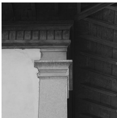
Bâtiment RST, aile T, extrémité sud, détail d'un pilier d'angle de l'ancienne loggia du 1er étage Phot. Didier Gourbin IVR82_20056900330NUC
