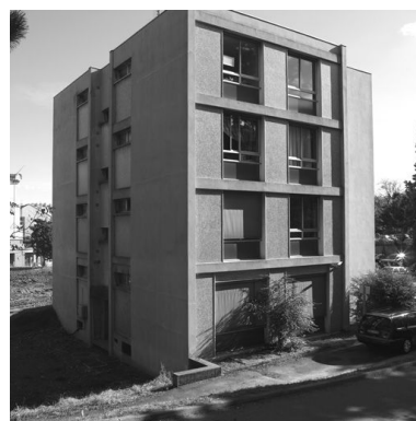
Bâtiment U, élévations est et nord Phot. Didier Gourbin IVR82_20056900340NUC
