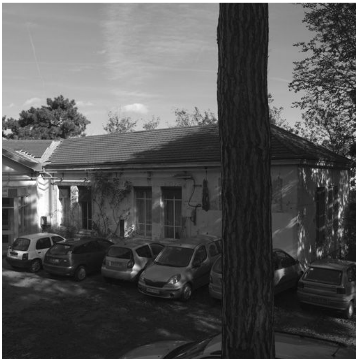
Bâtiment V, aile sud
