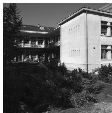
Bâtiment W, vue générale sur la cour est Phot. Didier Gourbin IVR82_20056900331NUC
