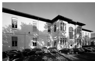
Bâtiment RST, aile T, élévation est Phot. Didier Gourbin IVR82_20046901578V
