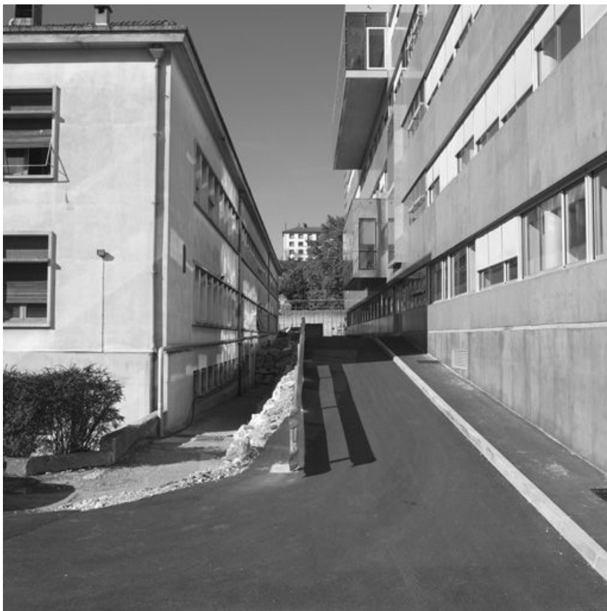
Bâtiment W, aile nord, élévation nord (à gauche)
