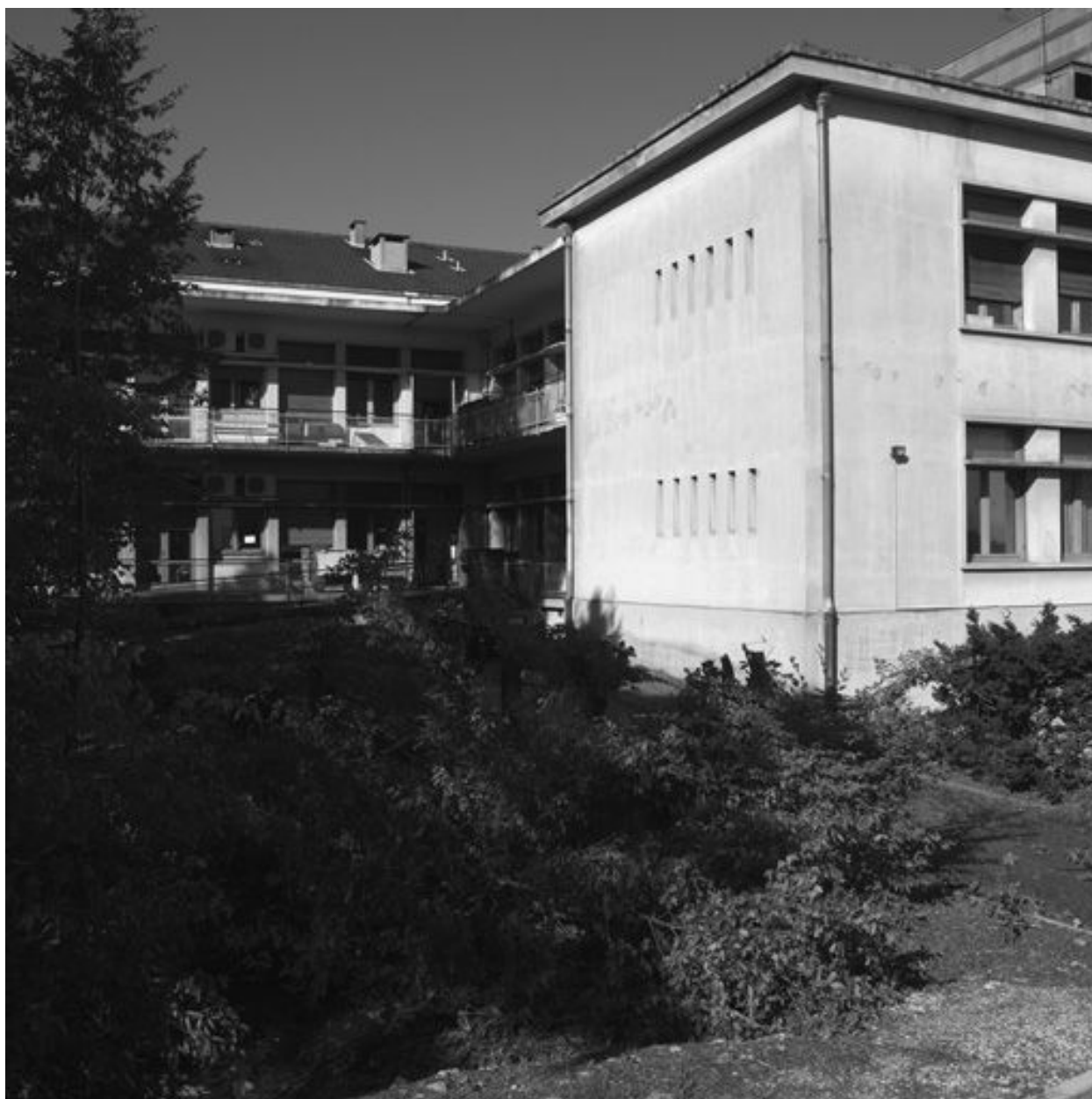
Bâtiment W, vue générale sur la cour est
