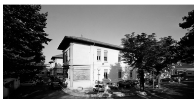
Bâtiment RST, vue générale depuis le côté est des logias aux extrémités des trois ailes Phot. Didier Gourbin IVR82_20046901577V
