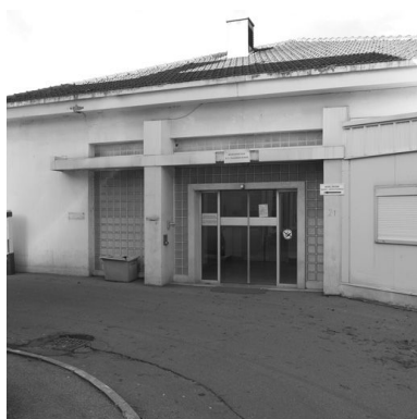
Bâtiment W, entrée principale au sud Phot. Didier Gourbin IVR82_20056900343NUC
