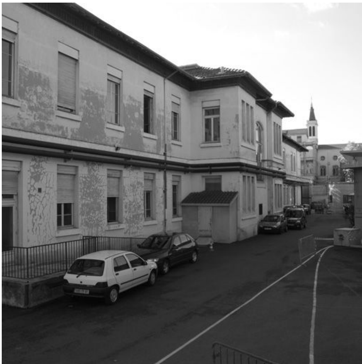
Bâtiment RST, aile R, façade ouest
