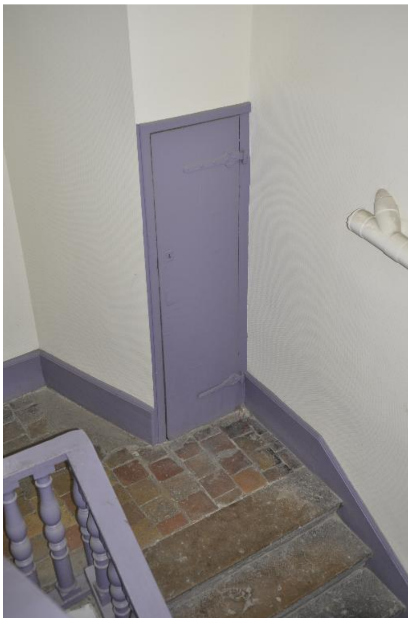
Latrine sur le premier palier intermédiaire de l'escalier du n°27 impasse Gigodot
