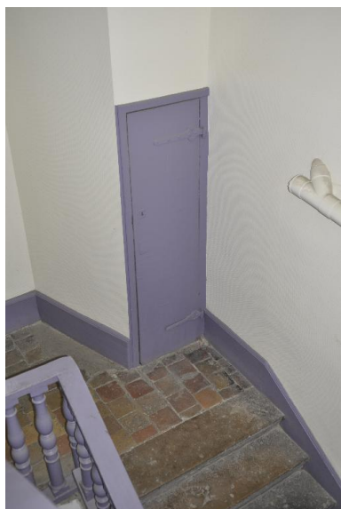
Latrine sur le premier palier intermédiaire de l'escalier du n°27 impasse Gigodot Phot. Nadine Halitim-Dubois IVR82_20136900471NUCA
