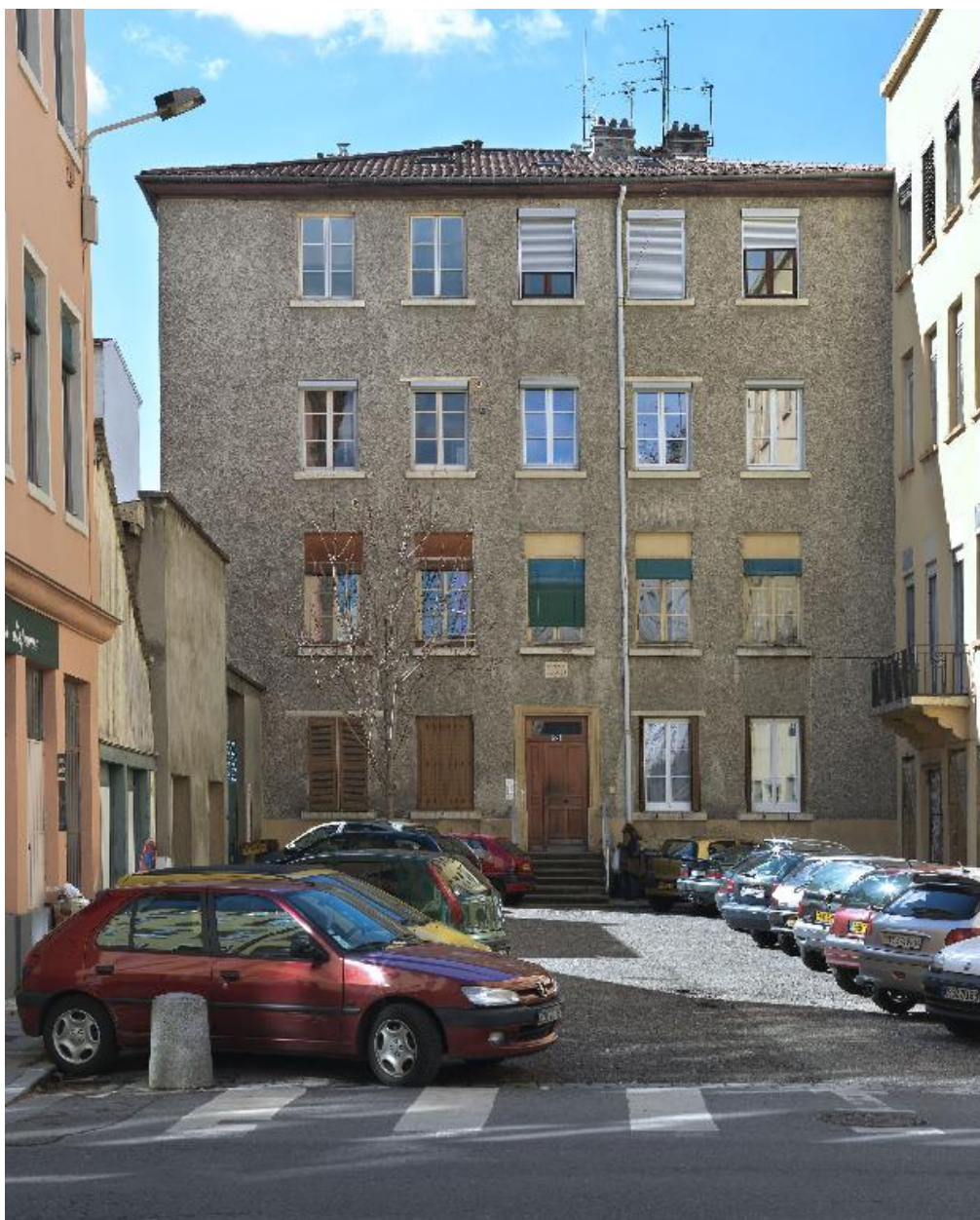
Vue d'ensemble du n°27 impasse Gigodot depuis l'ouest
