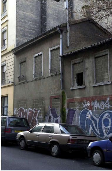
Façade principale sur rue Phot. Bernard Ducouret IVR82_20016900168NUCA
