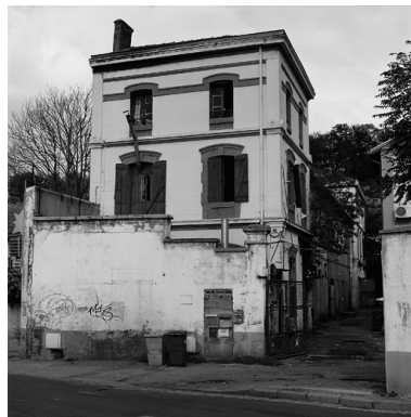
Vue générale est Phot. Didier Gourbin IVR82_20036901671X
