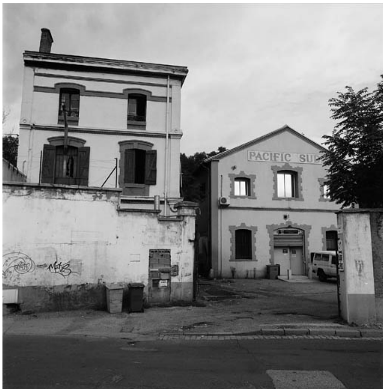
Vue d'ensemble est
