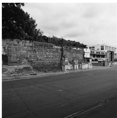
Détail mur Phot. Didier Gourbin IVR82_20036901676X
