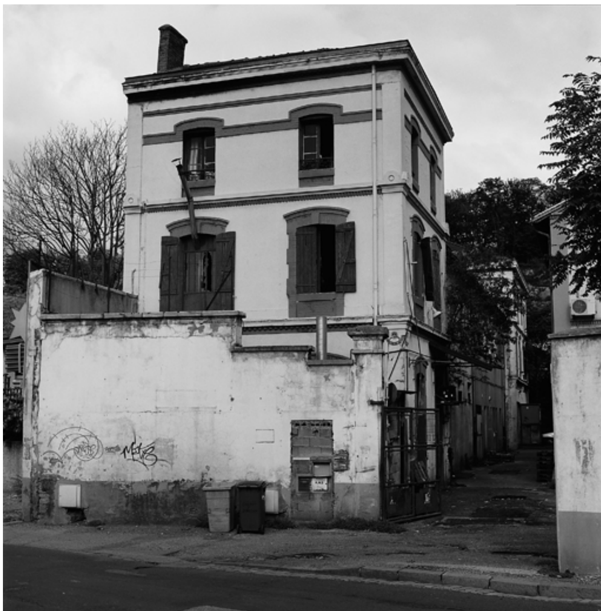
Vue générale est
