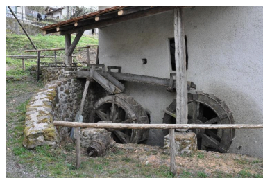
Vue des roues. Phot. Clara Bérelle IVR82_20147303183NUCA
