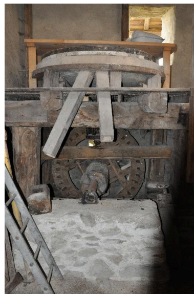
Vue des engrenages de la roue dont l'arbre est en métal. Phot. Clara Bérelle IVR82_20147303186NUCA
