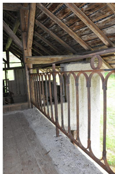
Vue de la balustrade réalisée en 2014 par l'association. Phot. Clara Bérelle IVR82_20147303189NUCA
