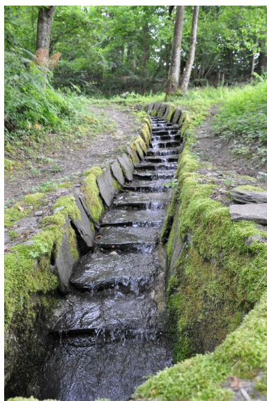
Canal d'aménée du moulin. Phot. Clara Bérelle IVR82_20147303181NUCA
