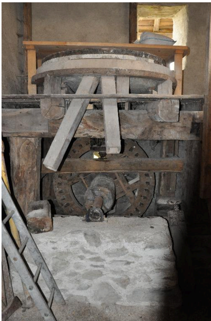
Vue des engrenages de la roue dont l'arbre est en métal.
