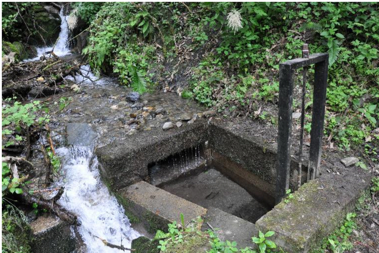
Vue de la prise d'eau.
