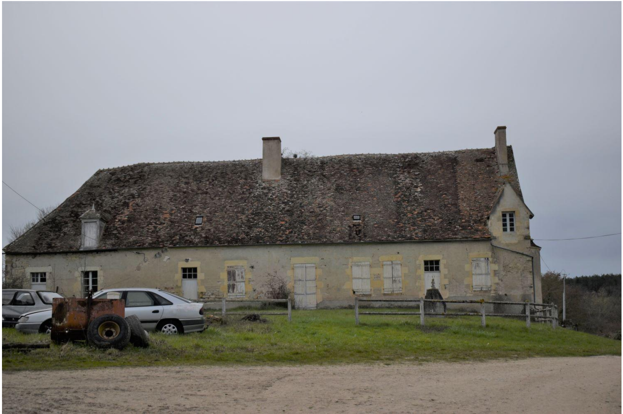
Vue générale de l'ancien logis façade est.
