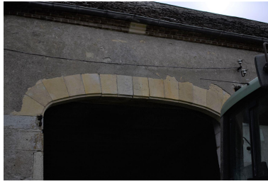
Détail de la grange : arc en anse de panier portant la date à la clef. Phot. Cécile Breton IVR84_20230300134NUC4A
