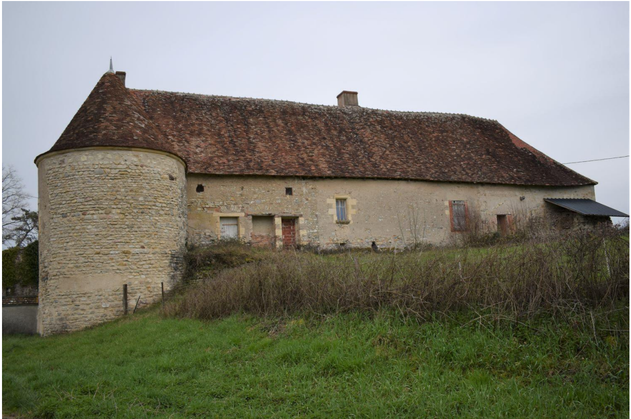
Vue de la tour et de la façade occidentale.
