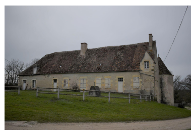
Vue générale de la façade est de l'ancien logis. Phot. Cécile Breton IVR84_20230300135NUC4A
