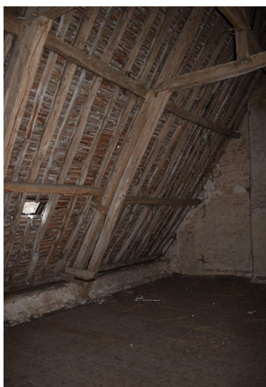
Vue de la charpente de l'ancien logis Phot. Cécile Breton IVR84_20230300143NUC4A
