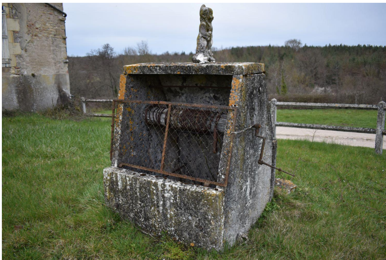
Vue générale du puits
