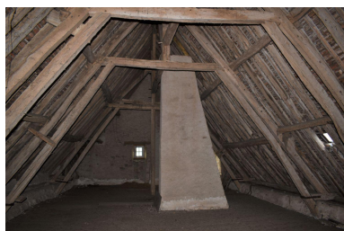
Vue de la charpente du grenier de l'ancien logis avec le conduit de la cheminée centrale. Phot. Cécile Breton IVR84_20230300145NUC4A
