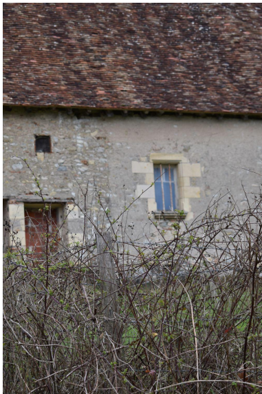
Façade occidentale : détail des baies. Phot. Cécile Breton IVR84_20230300150NUC4A
