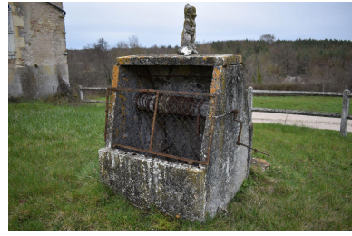
Vue générale du puits Phot. Cécile Breton IVR84_20230300147NUC4A
