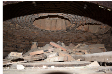
Vue de la voute de briques du four. Phot. Cécile Breton IVR84_20230300137NUC4A
