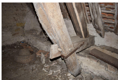
Détail de la pièce assemblant l'arbalétrier à la jambe de force. Au premier plan assemblage de la pièce à la jambe de force par tenon et mortaise chevillé. Phot. Cécile Breton IVR84_20230300146NUC4A
