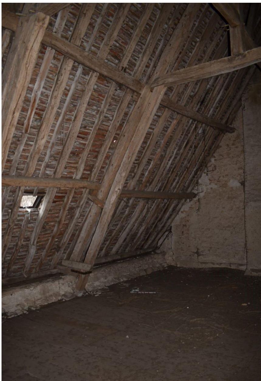
Vue de la charpente de l'ancien logis
