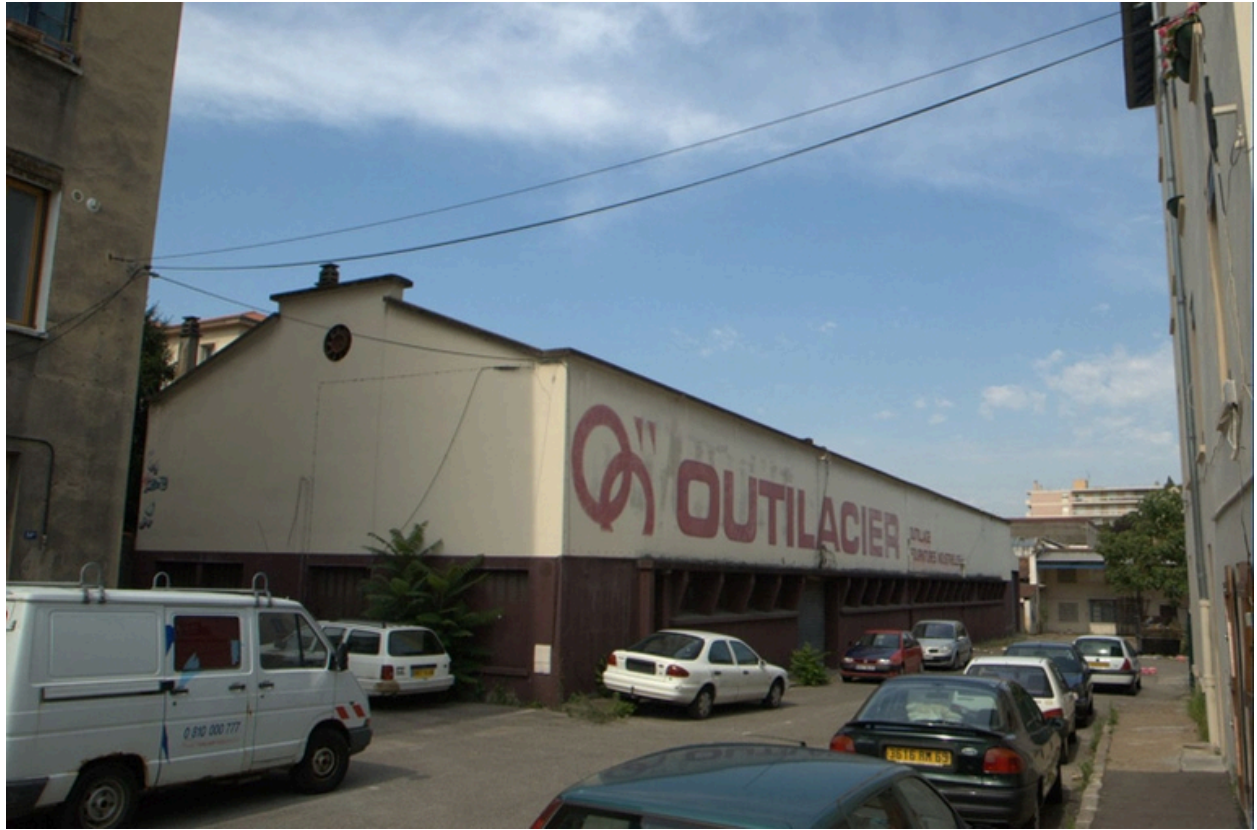
Vue est du bâtiment qui va être démoli
