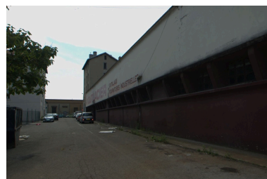
Vue ouest du site Phot. Nadine Halitim-Dubois IVR82_20086900540NUCA
