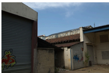
Lanterneau sur atelier de fond de parcelle Phot. Nadine Halitim-Dubois IVR82_20086900539NUCA
