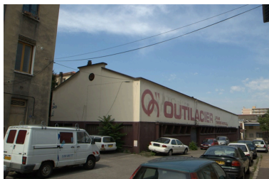
Vue est du bâtiment qui doit être démolit Phot. Nadine Halitim-Dubois IVR82_20086900533NUCA
