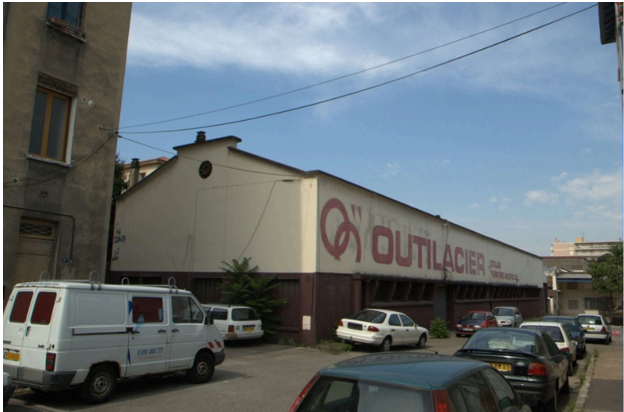
Vue est du bâtiment qui doit être démolé
