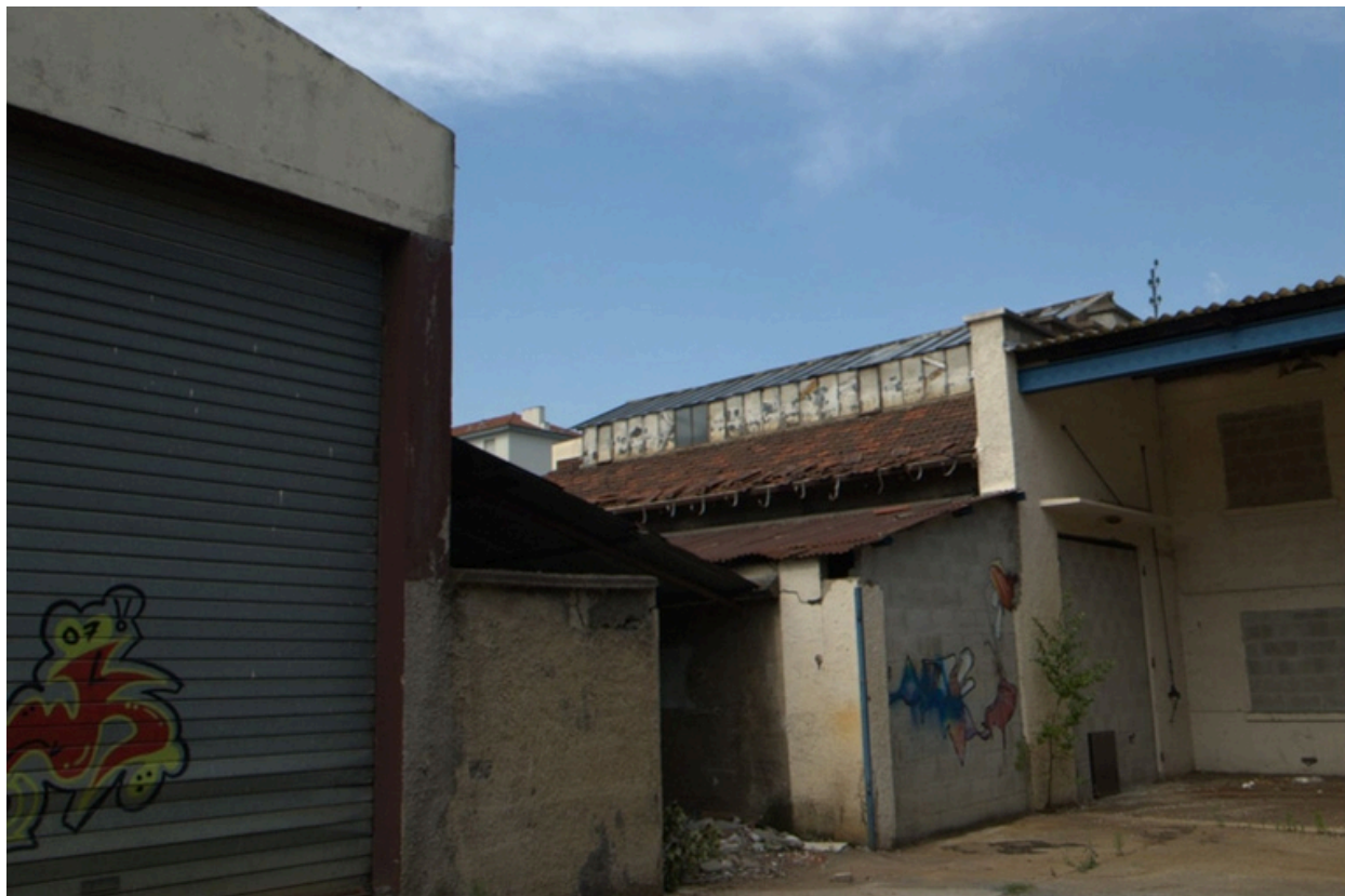
Lanterneau sur atelier de fond de parcelle
