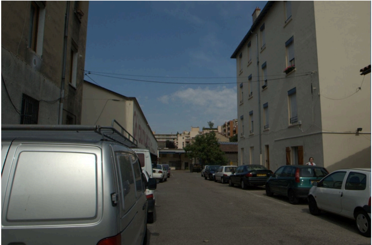
Vue d'ensemble de l'impasse Gazagnon angle rue Feuillat
