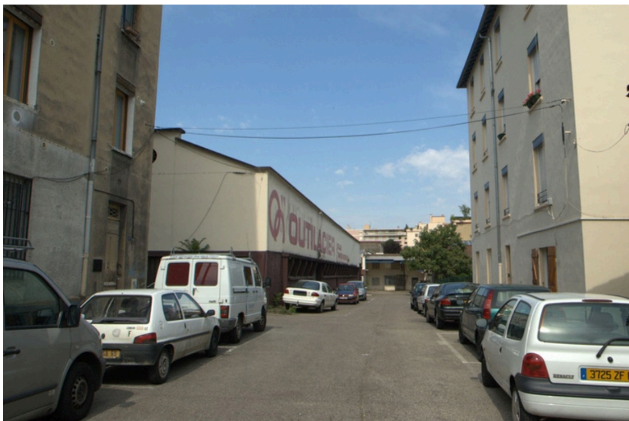
Vue d'ensemble de l'impasse Gazagnon
