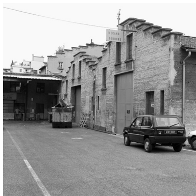
Vue générale sud-ouest Phot. Martial Couderette IVR82_20016903171X
