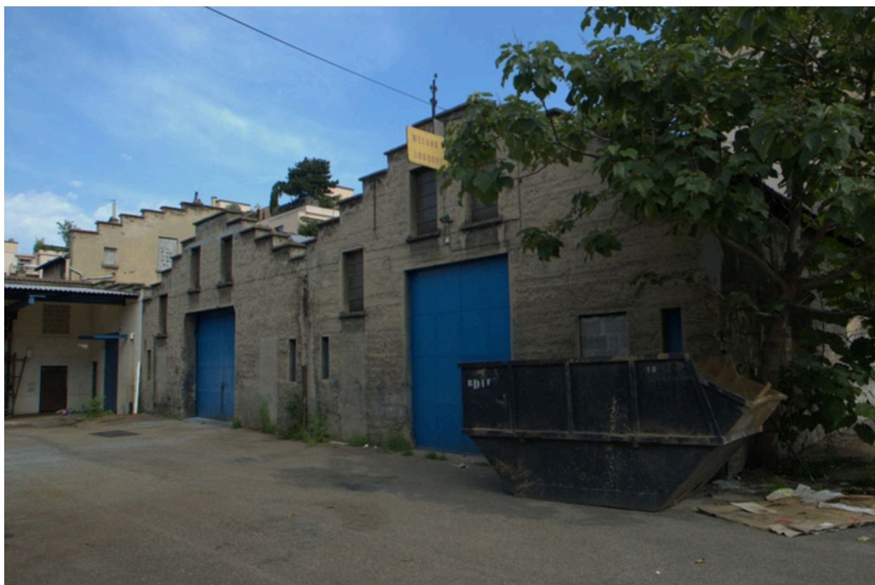
Vue sud-est du site
