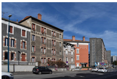
Elévations sur le boulevard Fleury (du 6 au 2) Phot. Félicie Fougère IVR84_20246300414NUCA
