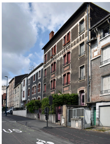
Elévations sur le boulevard Fleury (du 2bis au 8) Phot. Félicie Fougère IVR84_20246300410NUCA
