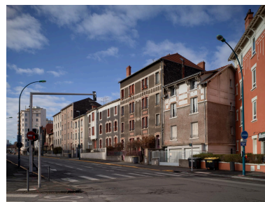
Front de boulevard, vue depuis le nord Phot. Christian Parisey IVR84_20246300352NUC4A
