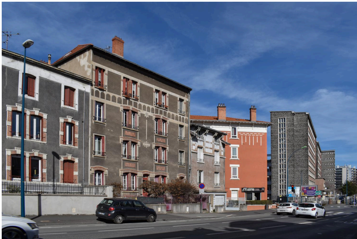
Elévations sur le boulevard Fleury (du 6 au 2)
