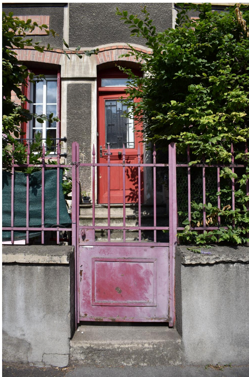
Porte d'entrée desservant le rez-de-chaussée
