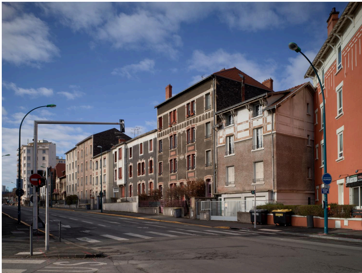
Front de boulevard, vue depuis le nord
