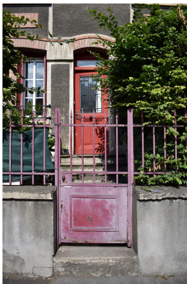
Porte d'entrée desservant le rez-de-chaussée
