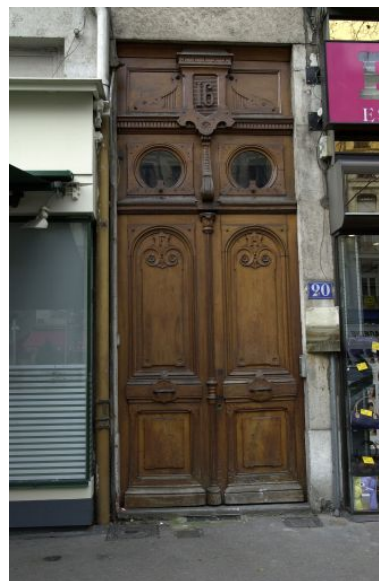
Huisserie de la porte d'entrée Phot. Chantal Archer-Galéa IVR82_20016900266NUCA
